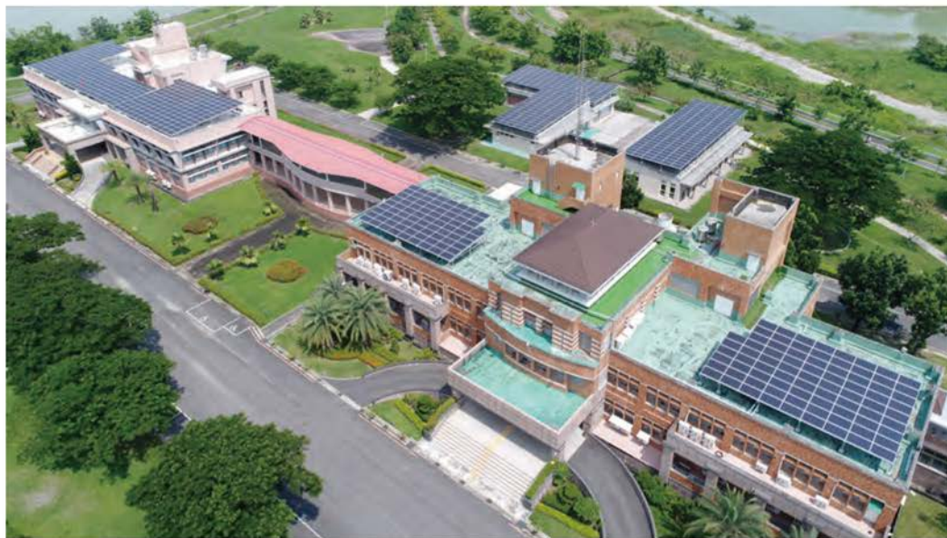
(二) 屋頂太陽能綠電發電系統 (屋頂型)
