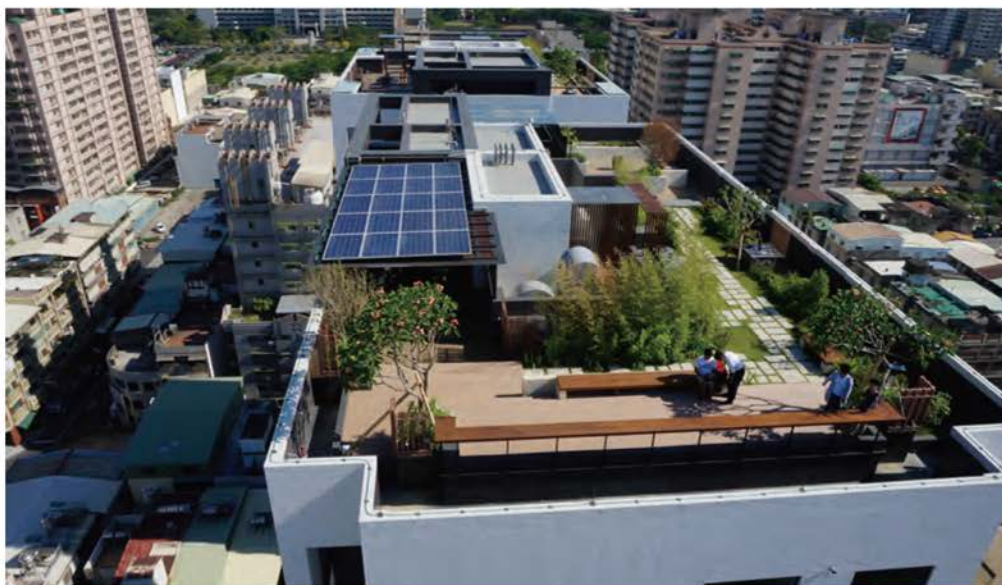
高雄市鳳山區 設置類型：集合住宅建築類 設置容量：5Kwp 發電量：6,387度/年
