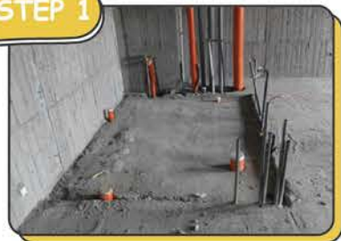
水電配管及降板
