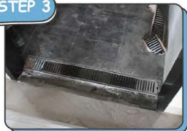
完成磁磚鋪地截水溝施作
