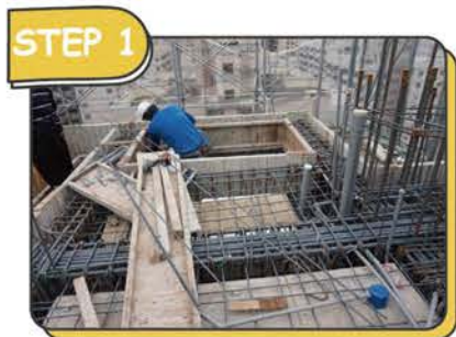
綁鋼筋裝設模板灌漿
