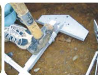
2. 將錨釘板打入側壁
