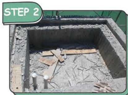
灌漿完成拆除模板
