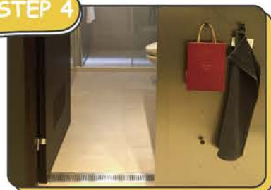
通用化浴廁完成
