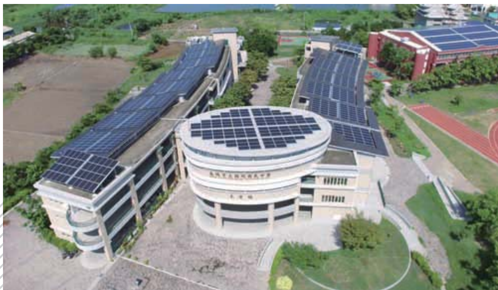
彌陀國民中學 設置容量：499.92 Kwp 發電量：638,647.8度/年
