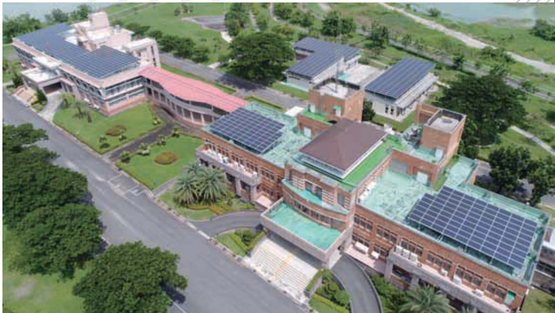
(二) 屋頂太陽能綠電發電系統 (屋頂型)
