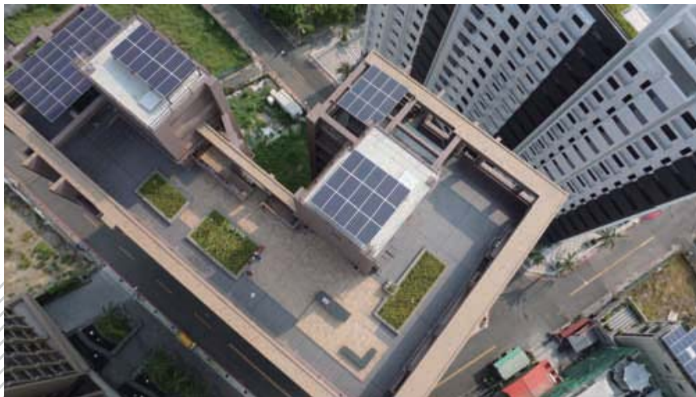
高雄市仁武區 設置類型：集合住宅建築類 設置容量：15Kwp 發電量：19,192度/年
