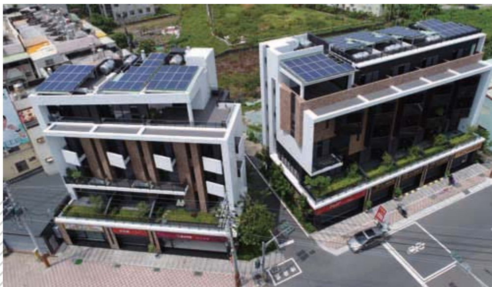
高雄市仁武區(採用高雄市高雄盾設計及鼓勵回饋辦法) 設置類型：透天住宅建築類 設置容量：一戶3 Kwp 發電量：3,832.5度/年
