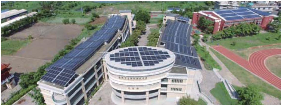
彌陀國中 光電屋頂
