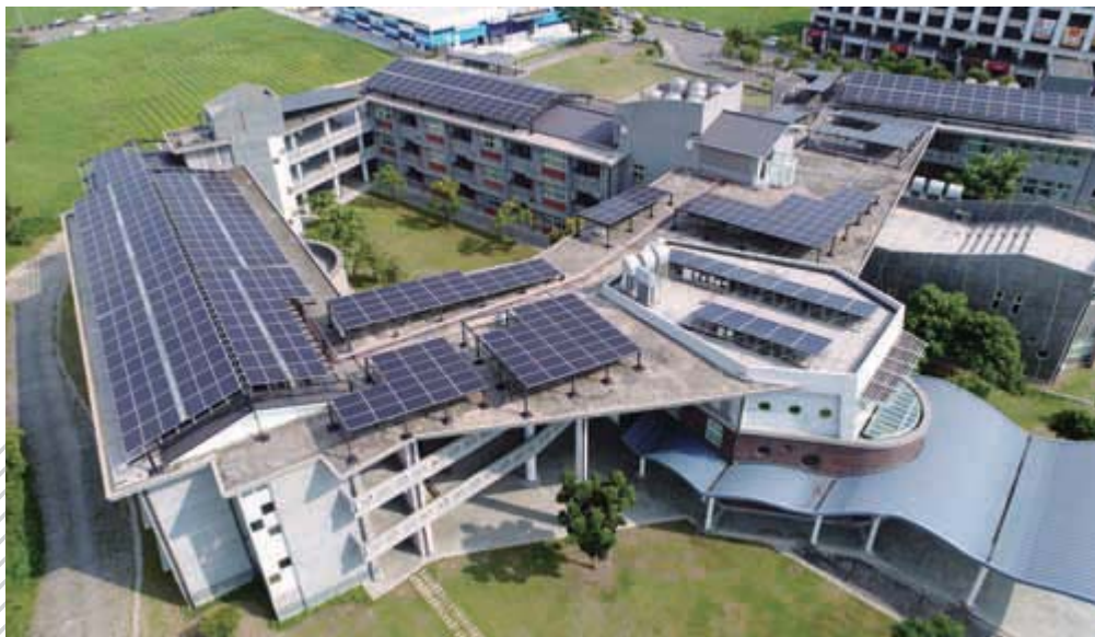
高雄市鳳翔國中 屋頂型279.66瓩，風雨球場689.12瓩 總建置量為968.78瓩
