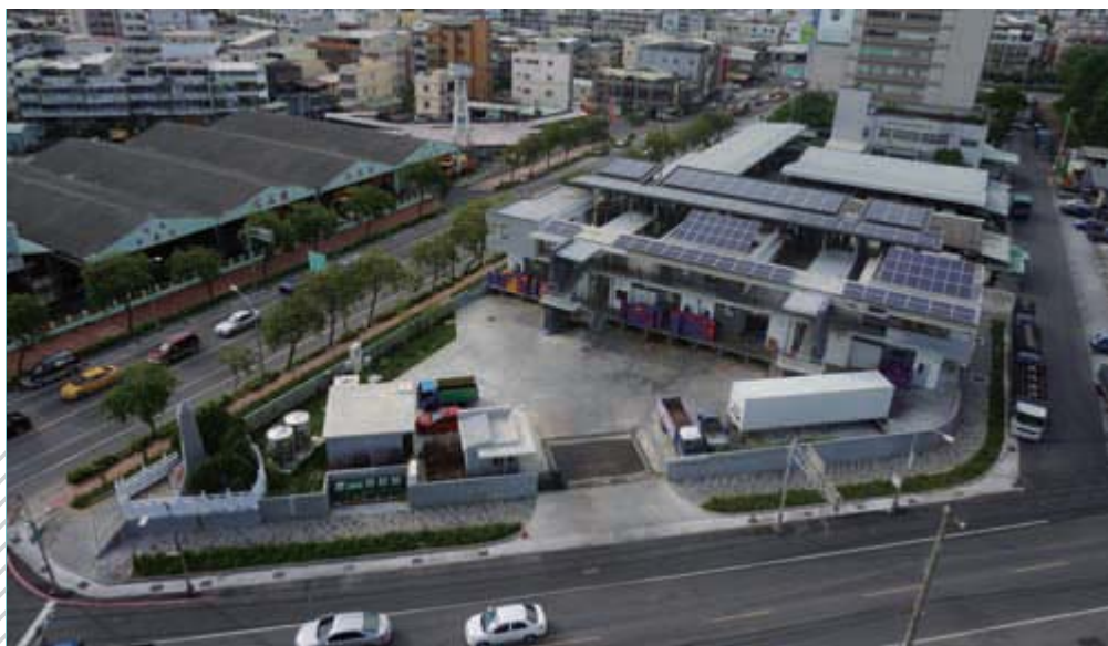
家禽市場電宰場 設置類型：公有建築類 設置容量：54.96Kwp 發電量：70,211度/年
