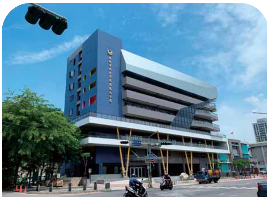
※商辦建築(B)組—高雄市政府警察局鼓山分局辦公大樓重建工程
