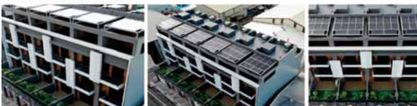
高雄層太陽光電設施實例
