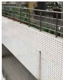
基地排水現況
