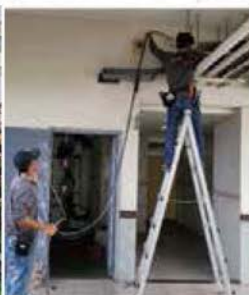
自動澆灌系統施工
