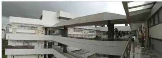
國際大樓西向建築外觀
