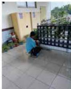
植生牆鍍鋅 金屬架構施工
