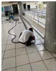
植生牆槽盆 架構施工
