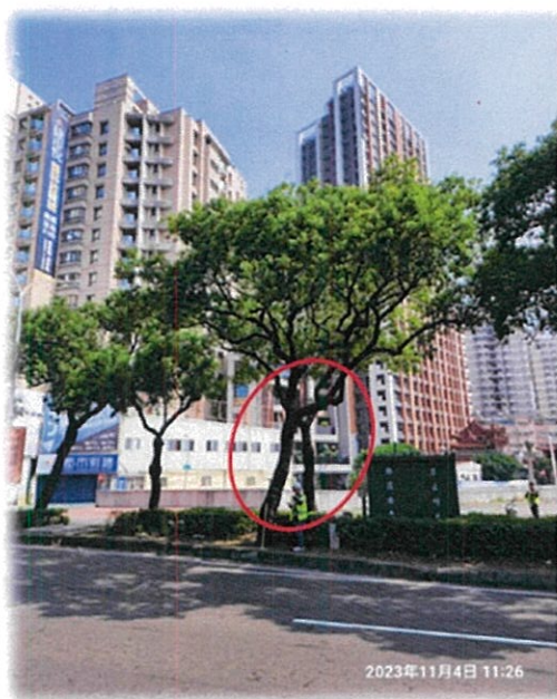
民族路及建工路口 樹木結構缺陷與樹型不良
