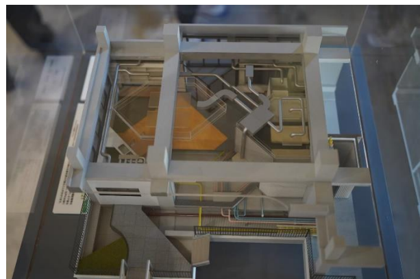
圖64 NEXT 21方便維修、更換的管道設計
