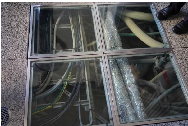
圖64 NEXT 21方便維修、更換的管道設計
