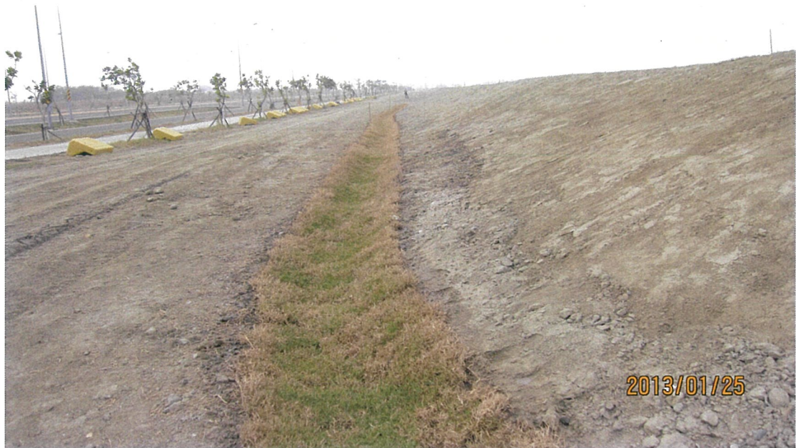
圖六、阻隔設施帶完成後照片
