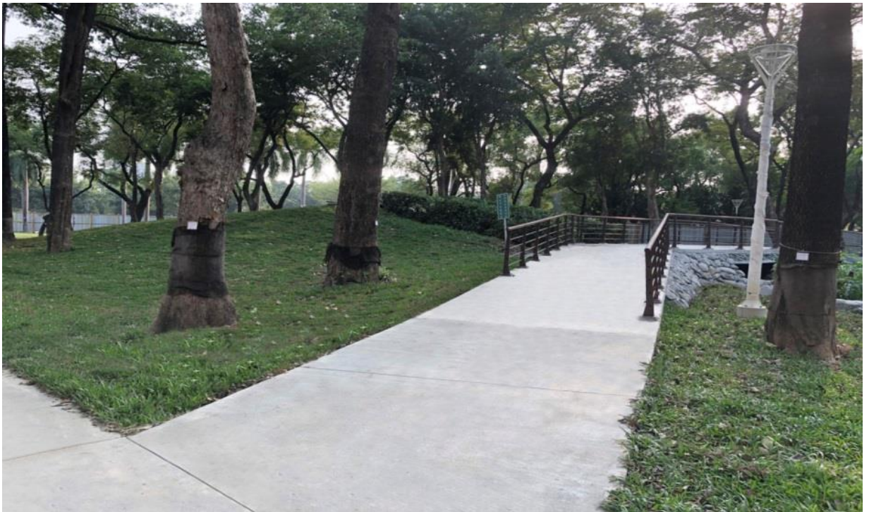
圖 21 景觀橋（施工前）vs 景觀橋（施工後）—木質橋梁改為 RC 橋梁，提升安全性且利於維護。
