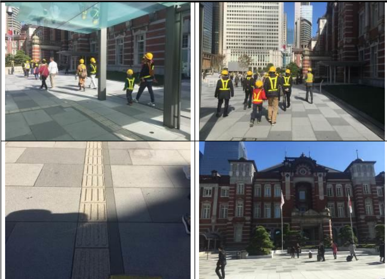
東京車站建築與施工現況。
