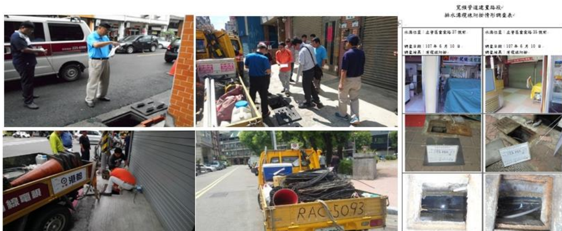
圖4-2 跨機關聯合清理排水溝附掛寬頻纜線
