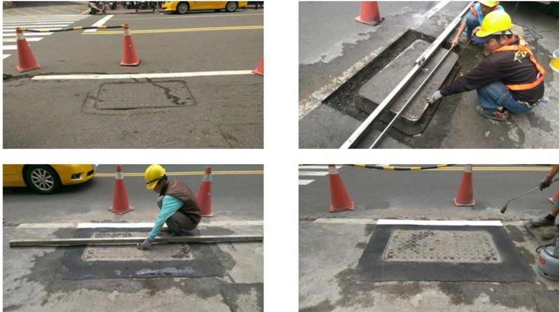
圖3-1 孔蓋齊平作業
