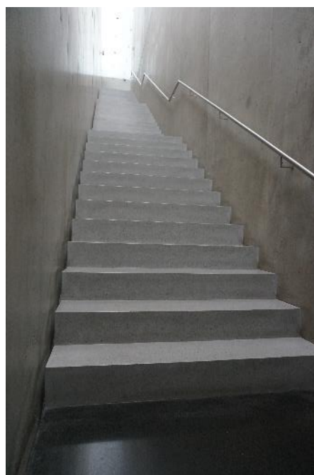
圖 43 內部垂直動線樓梯
