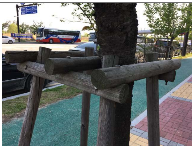
支架以木頭支架，支架間以鐵釘固定
