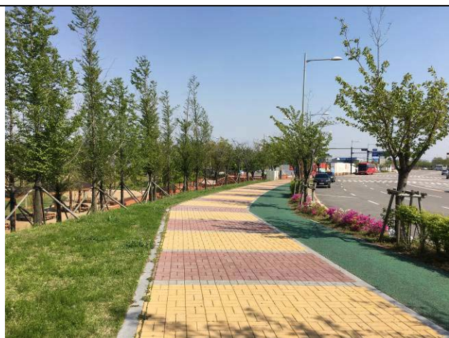
人行道與自行車道共構，以鋪面材質及顏色做為區隔，馬路與自行車道間又以綠帶阻隔
