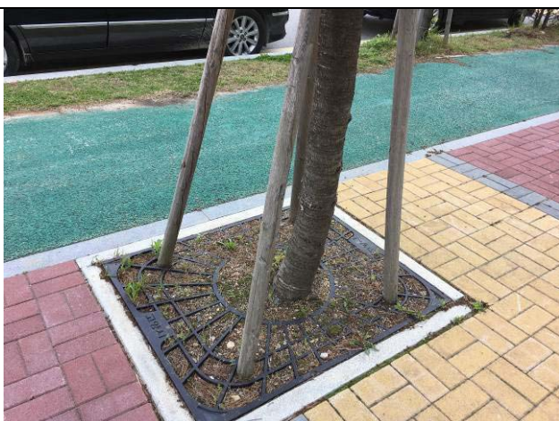
樹穴設置樹穴蓋板，提供樹木根系透氣及透水功能
