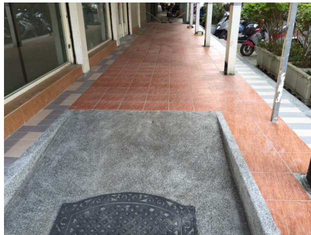
圖五、騎樓高低差以斜坡方式改善
