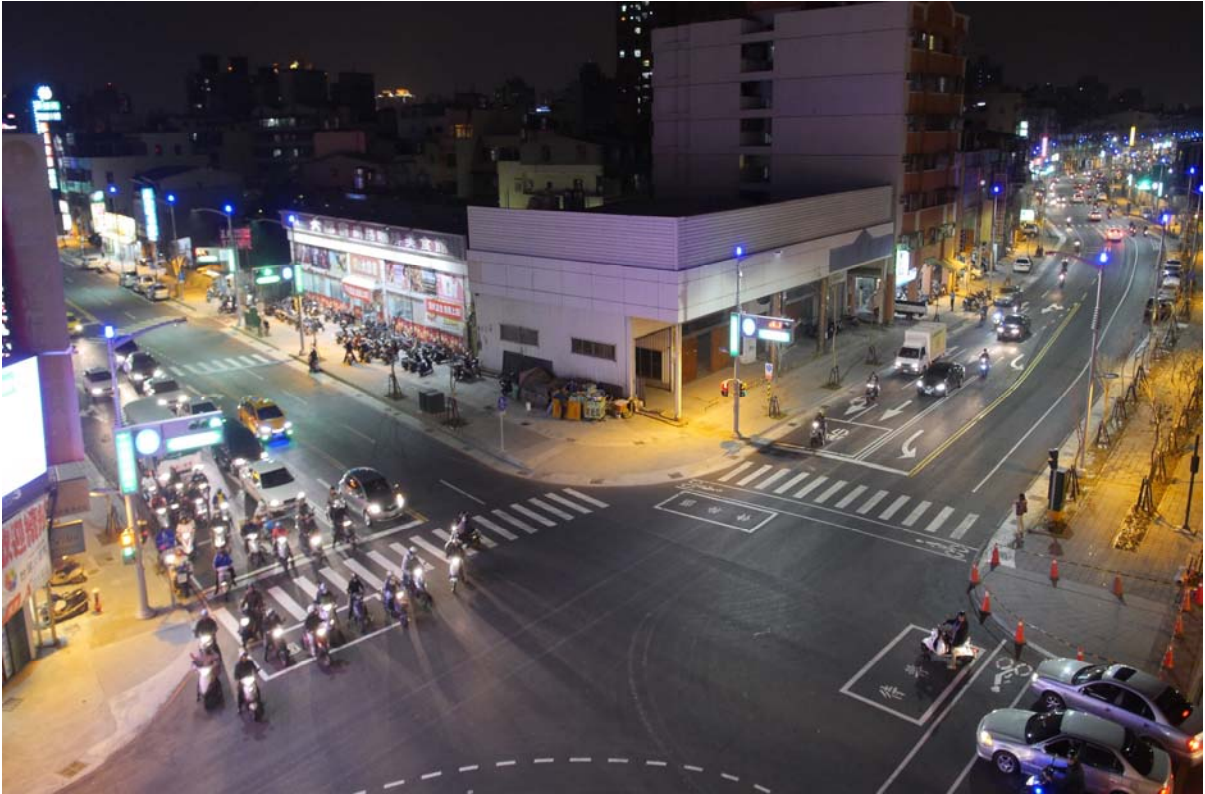
道路完工後現場夜間照片
