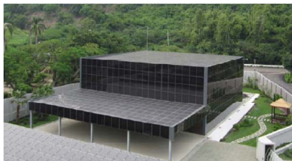
圖 3-22 金級光電智慧建築
