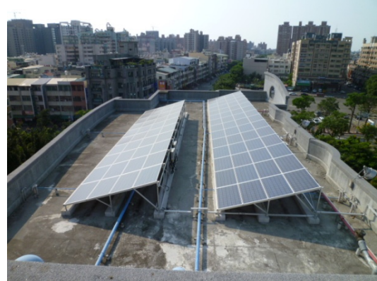
圖 3-44 公有屋頂裝設太陽光電，減少屋頂建材使用
