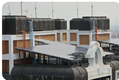
圖 3-10 陽光住宅大樓
