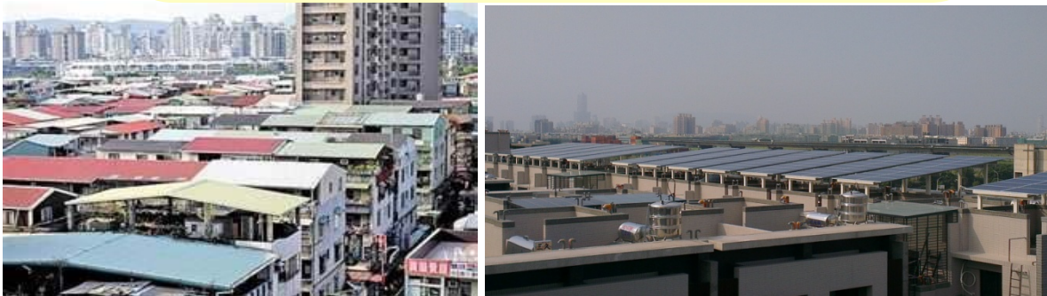
圖 3-50 屋頂違建與屋頂設置光電比較
