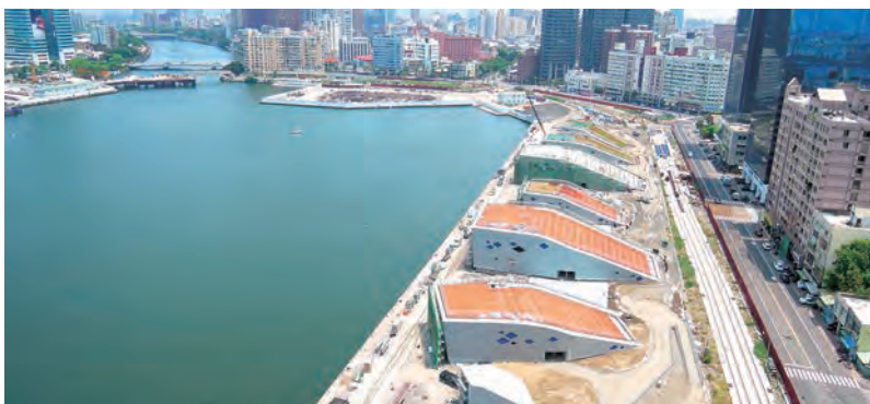
▲現況施工空照圖
