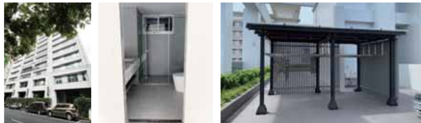
高雄市苓雅區 通用化浴廁 181.1 m 2 、太陽光電 13.2 kW
