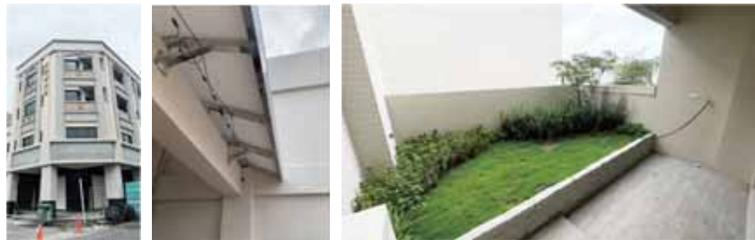
高雄市小港區 屋後綠能設施 (浴廁、廚房、餐廳、通道) 14.55 m 2 、雨水貯集、太陽光電 15.75 kW
