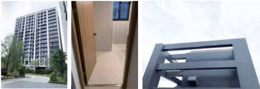
高雄市橋頭區 通用化設計之浴廁 491.73 m 2 、太陽光電 31.82 kW
