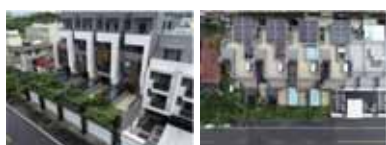
高雄市鳥松區 屋前綠能設施 28.64 m 2
