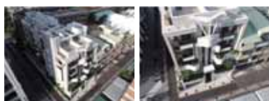
高雄市左營區 屋前綠能設施 14.87 m 2
