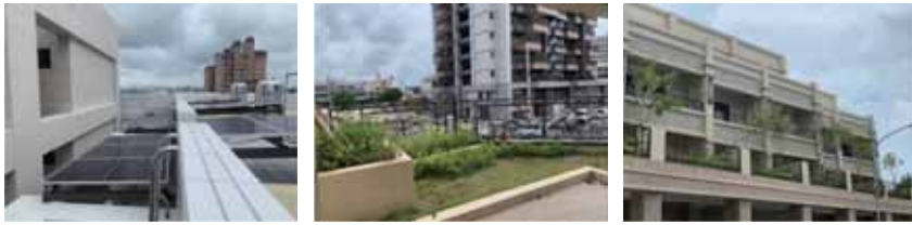
高雄市大寮區 屋前綠能設施 25.22 m 2 、太陽光電 2.07 kW、雨水貯集
