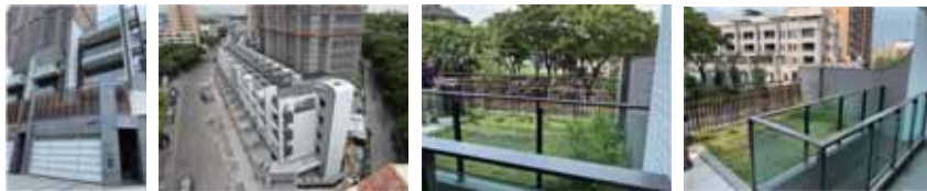
高雄市仁武區 景觀陽臺 2982.97 m 2 、通用化浴廁 365.54 m 2 、屋前綠能設施 538.09 m 2 太陽光電 3 kW
