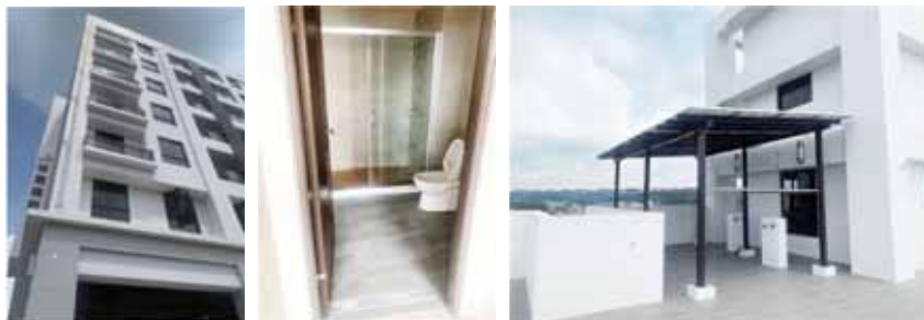
高雄市大樹區 通用化浴廁 32 m 2 、太陽光電 5120 kW
