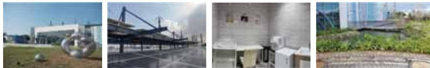
民間參與高雄市臨海污水處理廠暨放流水回收再利用 BTO 計畫
