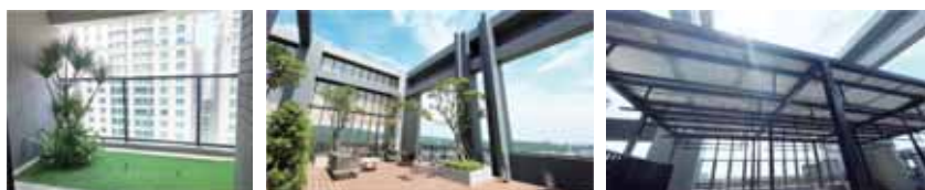
高雄市鼓山區 景觀陽臺 1511.72 m 2 、太陽光電 8.37 kW
