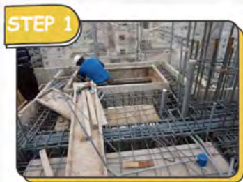
綁鋼筋裝設模板灌漿
