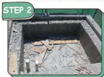
灌漿完成拆除模板
