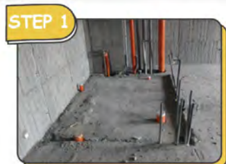
水管配電及降板
