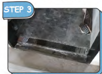
完成磁磚鋪地截水溝施作
