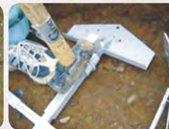
2. 將錨釘板打入側壁
