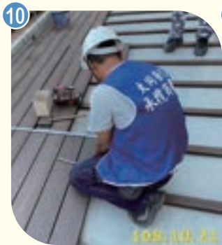
塑木地板鋪設
