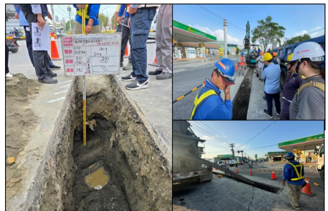
圖 7 管線試挖探管及復舊現況
