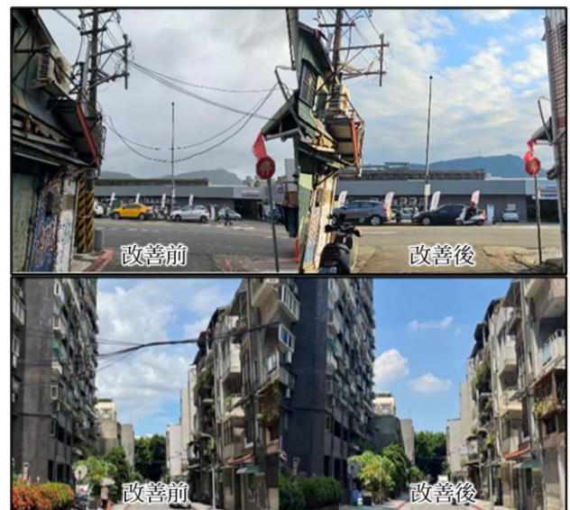
圖 4 巡查發現廢棄纜線清除作業改善前後照片
