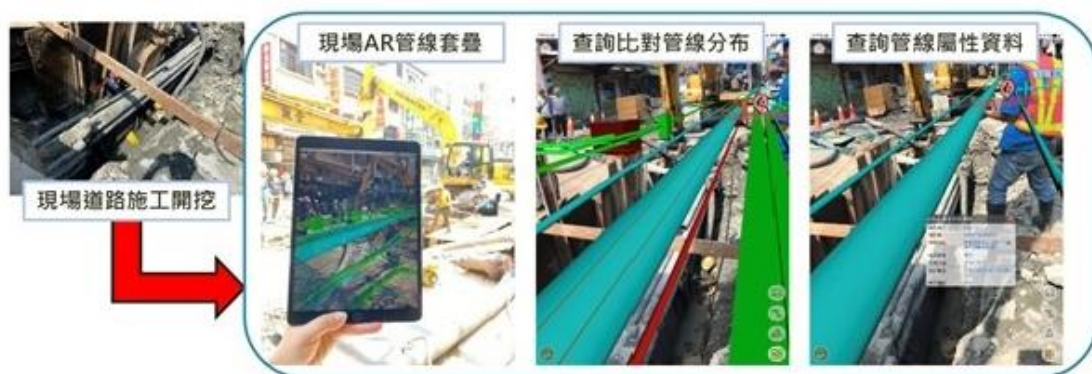
圖 3 公共管線資料庫應用對於現場施工管理之案例
