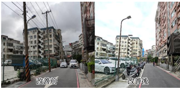
圖 10 北投區溫泉路電桿遷移改善照片
