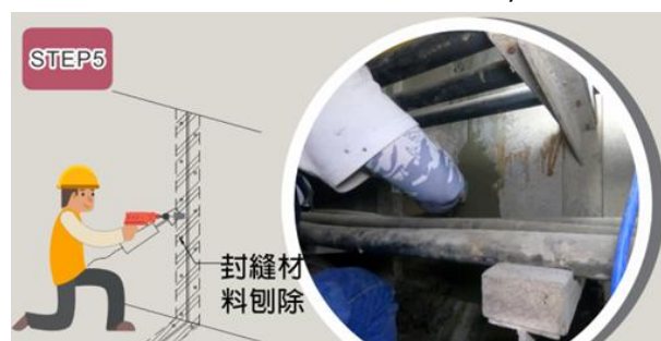
圖 20 步驟五 封縫材料刨除及治平施工/示意圖
