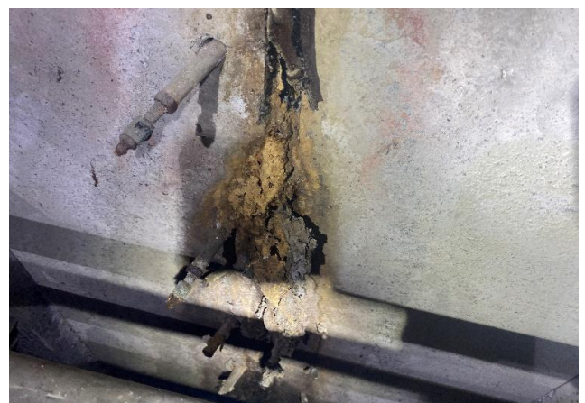
圖 13 過往以止水針灌注發泡劑止水
