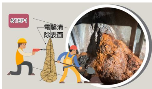
圖 16 步驟一 電鑿清除表面施工/示意圖
