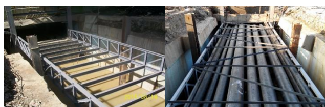
圖 10 管線吊掛保護作業示意圖
