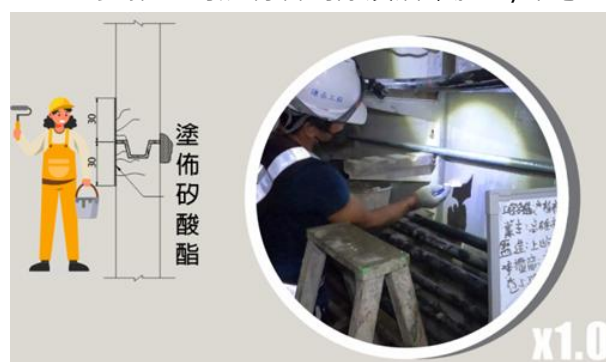
圖 21 步驟六 塗佈矽酸酯施工/示意圖
