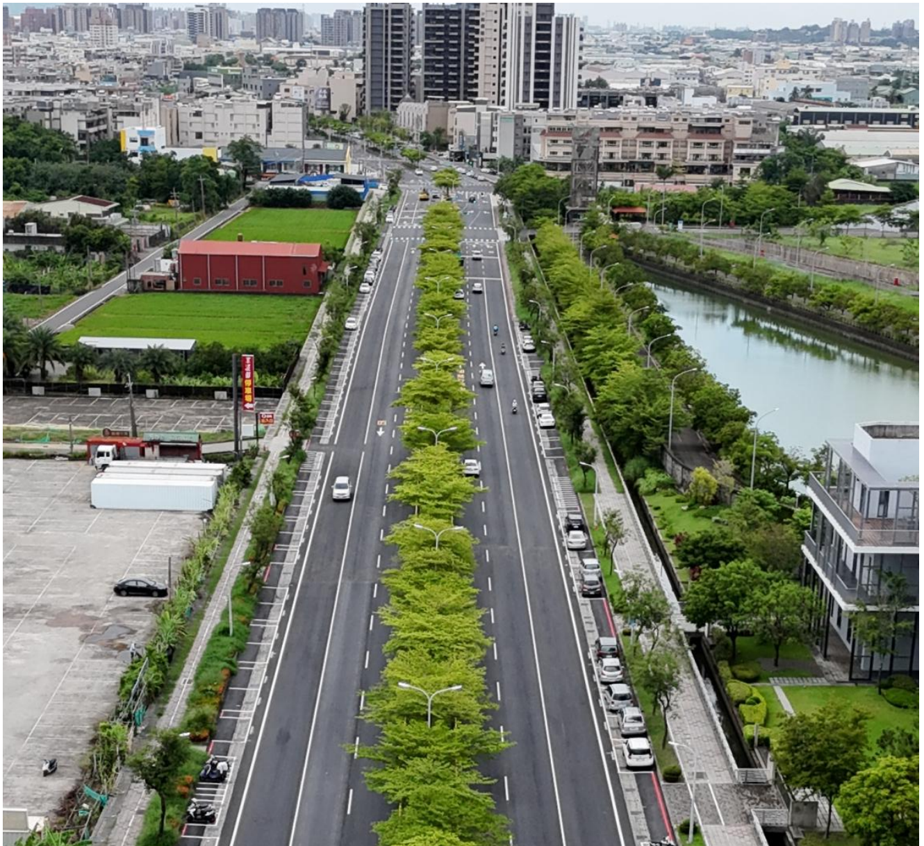
▲ 高雄市大寮區捷西路路面改善暨孔蓋下地工程
