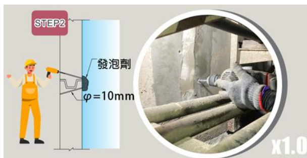
圖 17 步驟二 灌注發泡劑施工/示意圖
