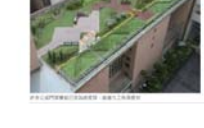
▲府電屋頂屋頂綠化,新屋設計應可達綠屋頂0%。(圖/高市工務局提供)
