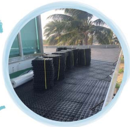
6.蓄排水板鋪設
