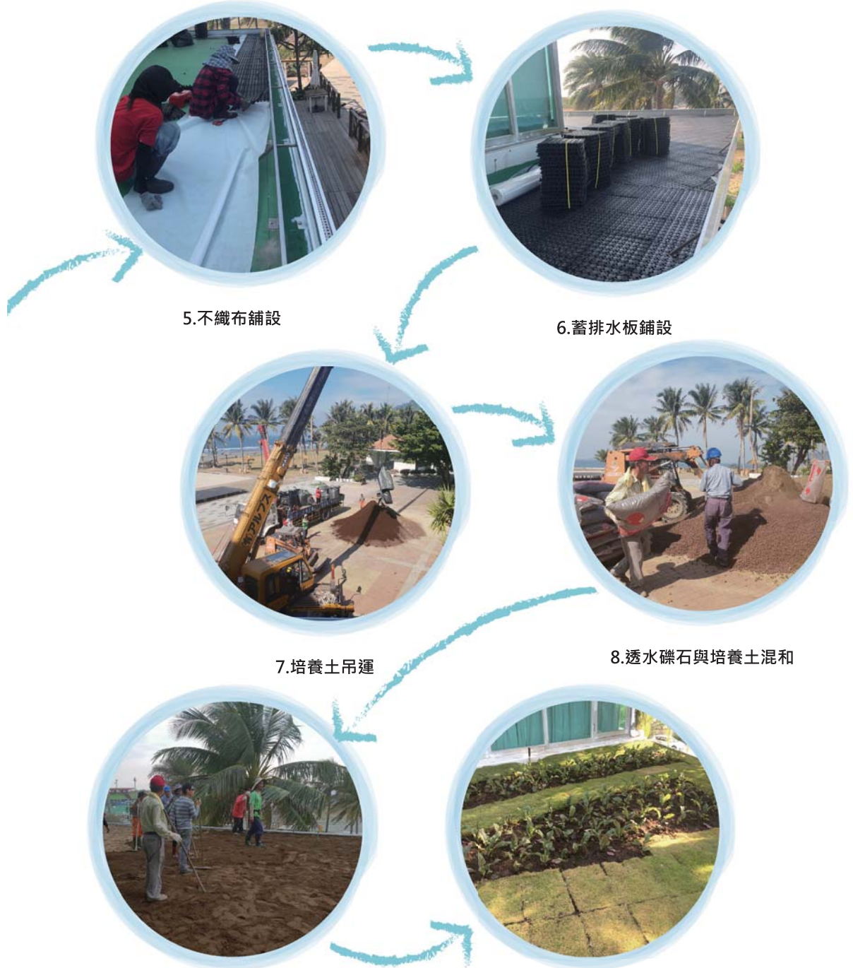
9.透水礫石與培養土鋪設
