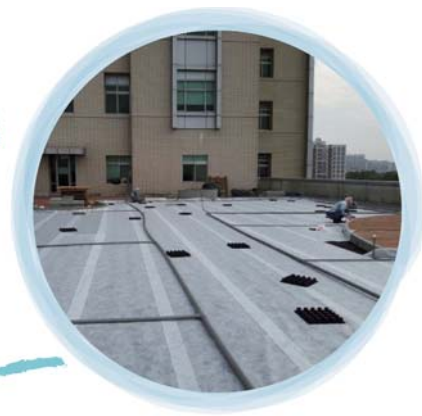
8. 噴灌系統管路施作
