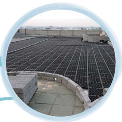
4. 蓄排水板鋪設
