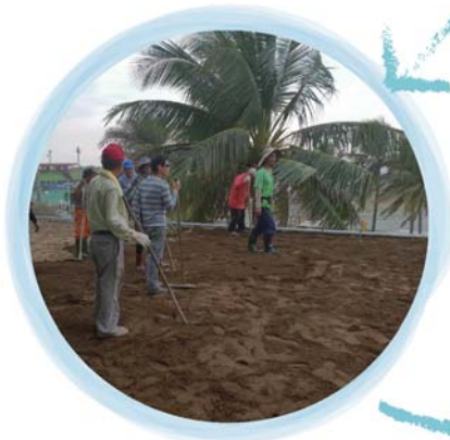
9.透水礫石與培養土鋪設
