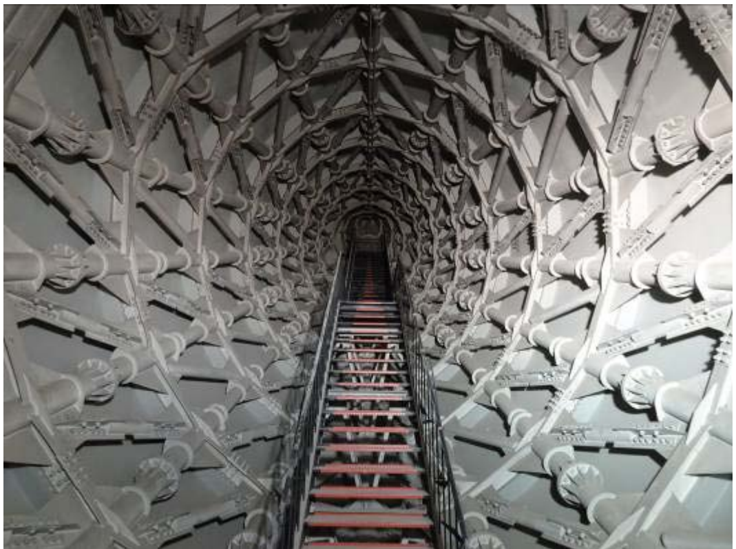
圖 96 太陽之塔兩壁的結構補強
