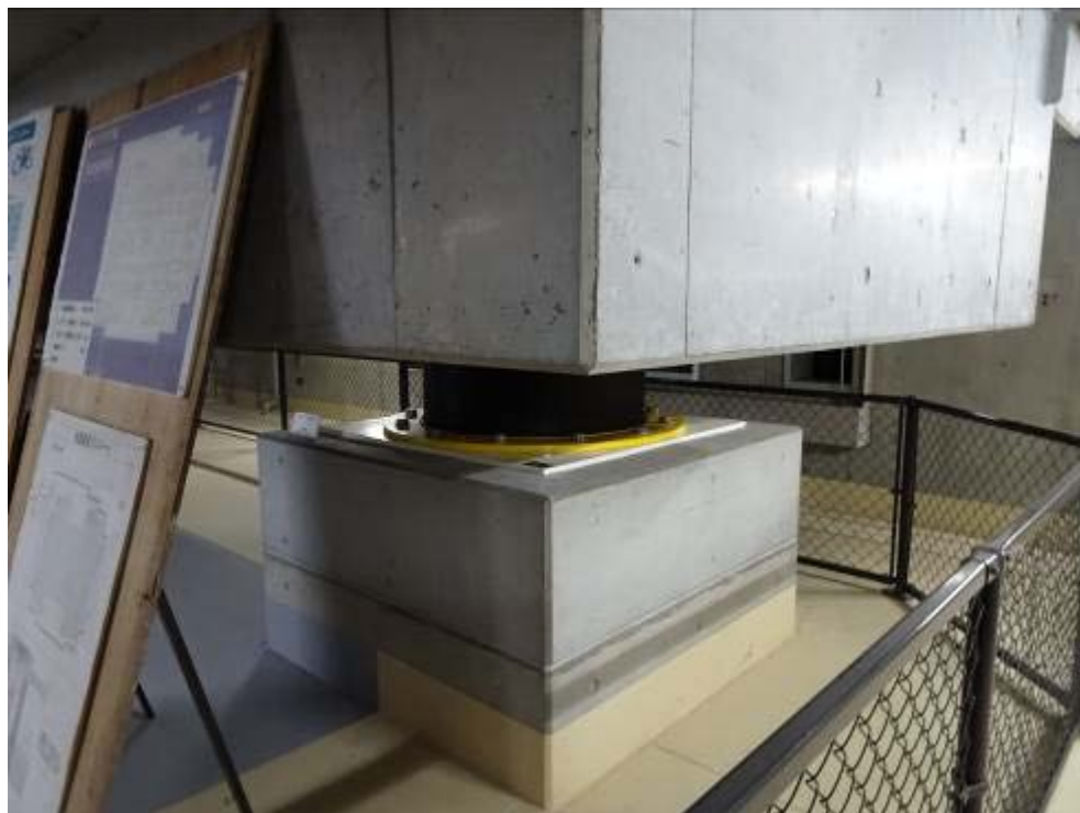
圖 80 中央公會堂的橡膠免震裝置
