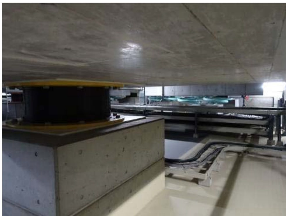
圖 81 中央公會堂地下室免震裝置
