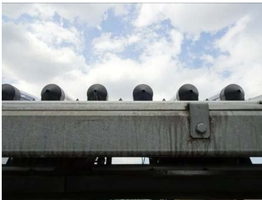
圖 44 南向屋頂上裝設太陽能板
