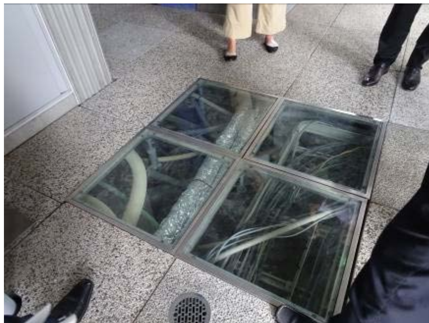
圖 48 方便維修、更換的管道設計
