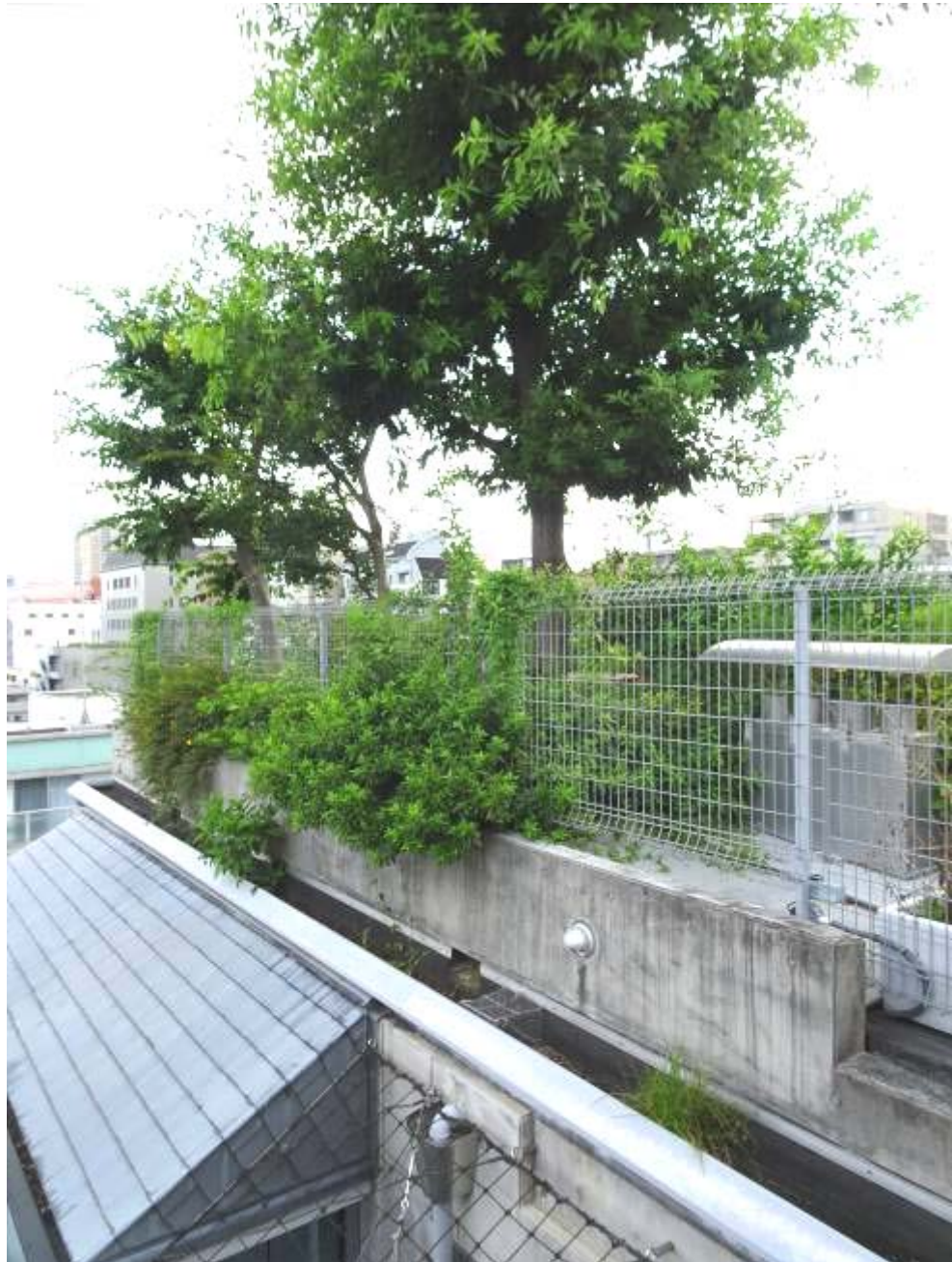
圖 41 足夠的覆土深度提供屋頂喬木良好的生長條件
