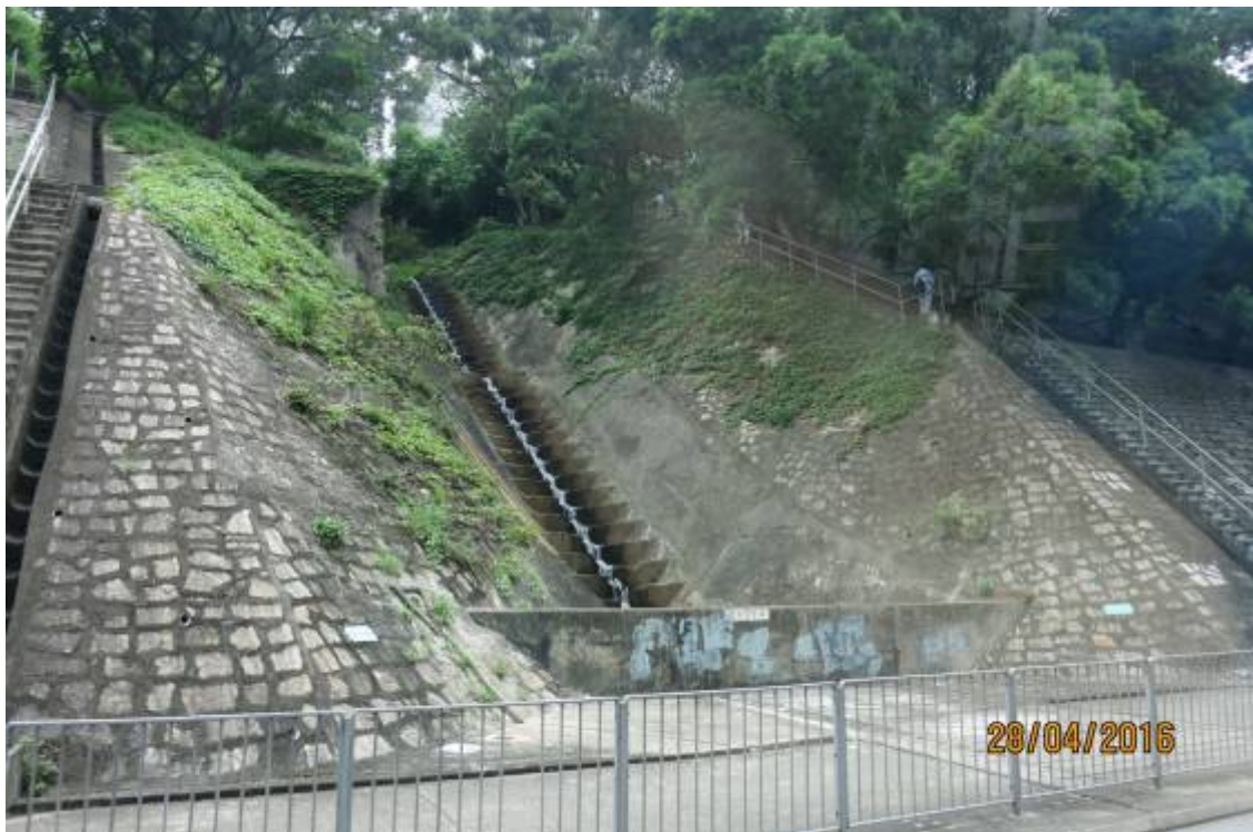
圖 45 邊坡設施與排水整治
