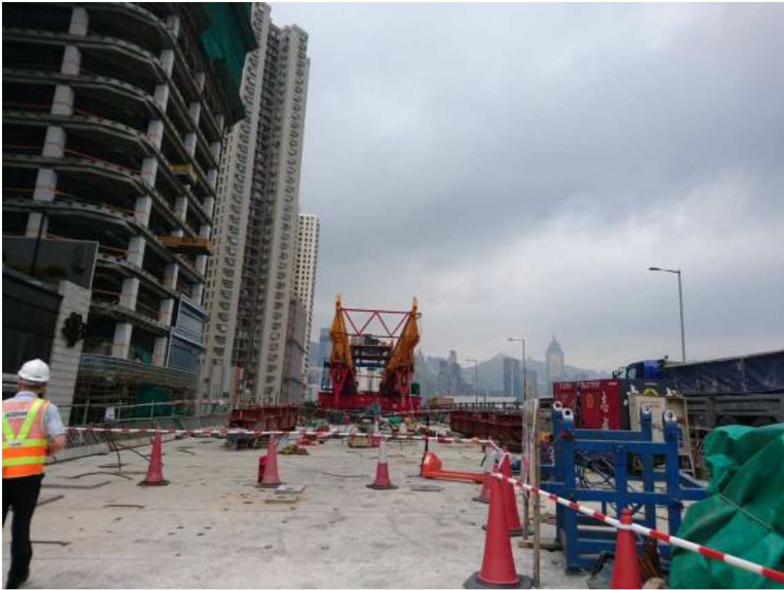
圖 18 中環灣仔繞道—北角段隧道及東區走廊連接路工程高架橋施工
