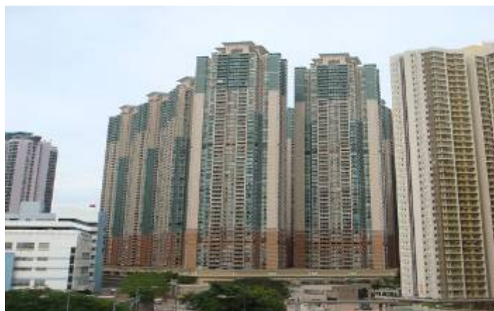
圖 25 調景嶺站鄰近開發大樓
