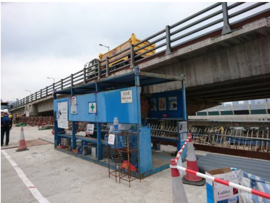
圖 35 施工現場設置救護站、施工人員休息室等設施
