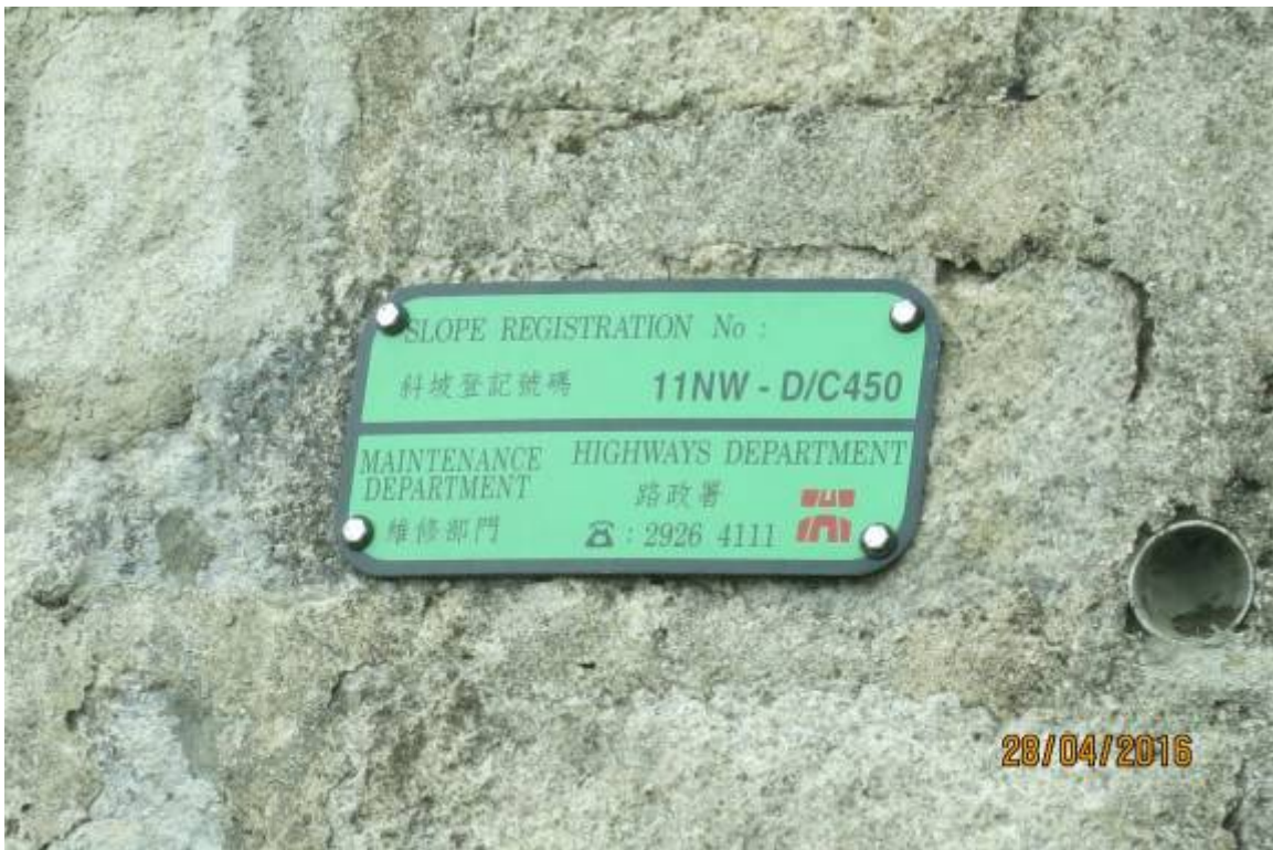
圖 48 邊坡編號與維修訊息告示
