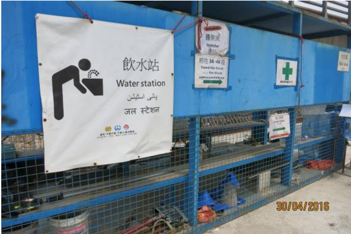
圖 36 施工現場設置飲水站等設施
