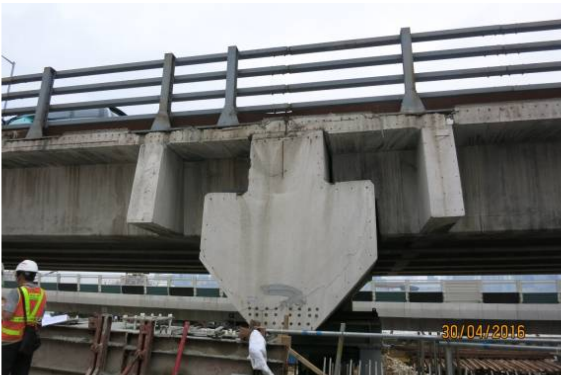
圖 13 中環灣仔繞道—北角段隧道及東區走廊連接路工程旁舊橋拆除
