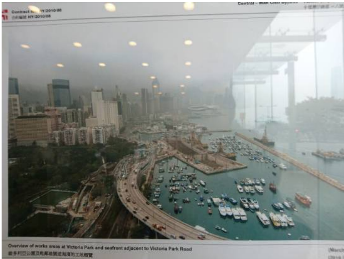
圖 11 中環灣仔繞道—北角段隧道及東區走廊連接路工程避風塘施工
