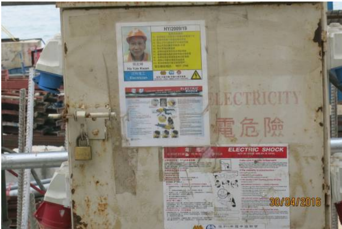
圖 39 施工現場電氣設置由專業註冊電工人員負責維管操作
