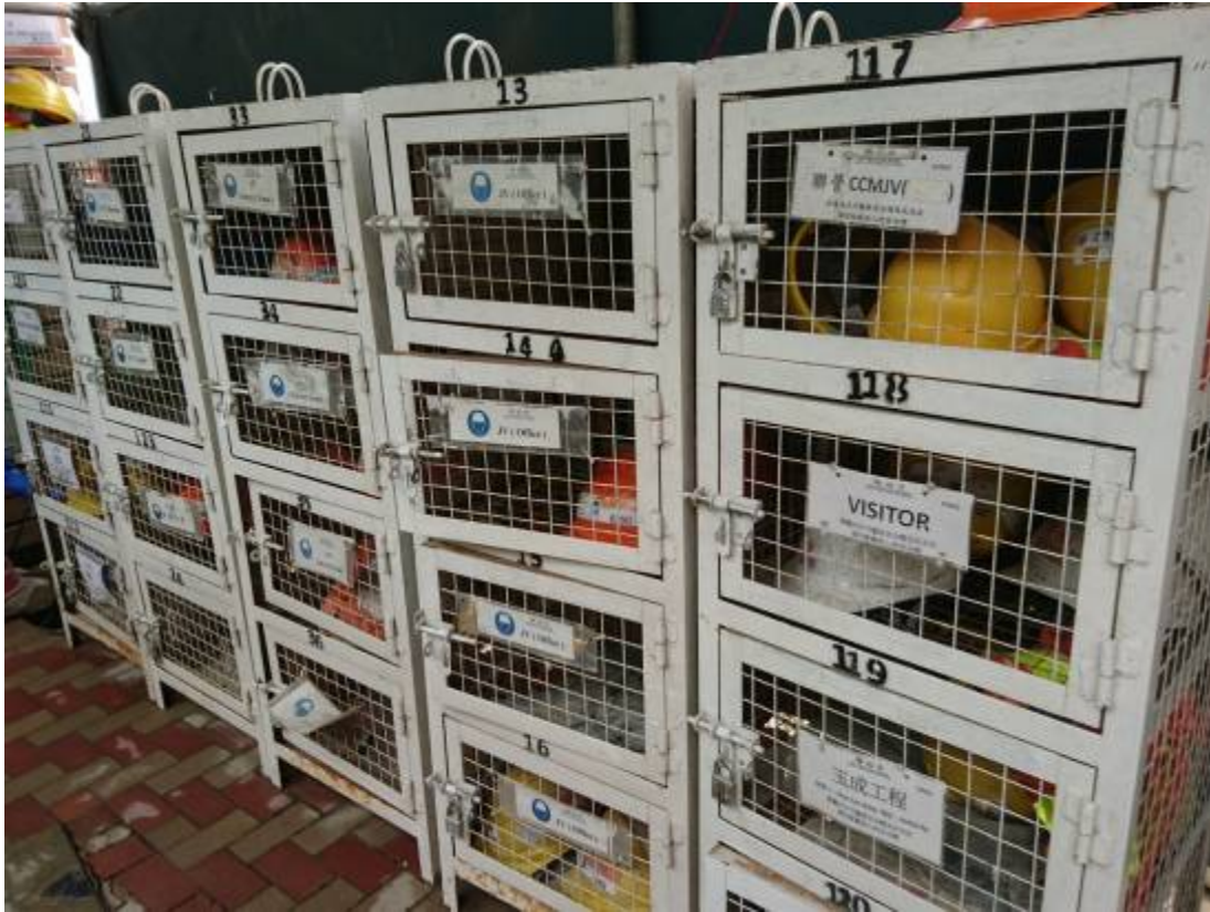
圖 38 施工現場設置施工人員物品設備保管設施
