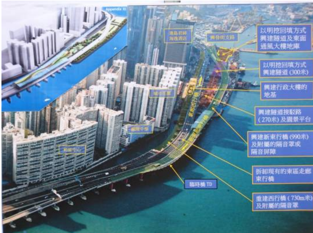
圖 10 中環灣仔繞道—北角段隧道及東區走廊連接路工程空拍示意圖
