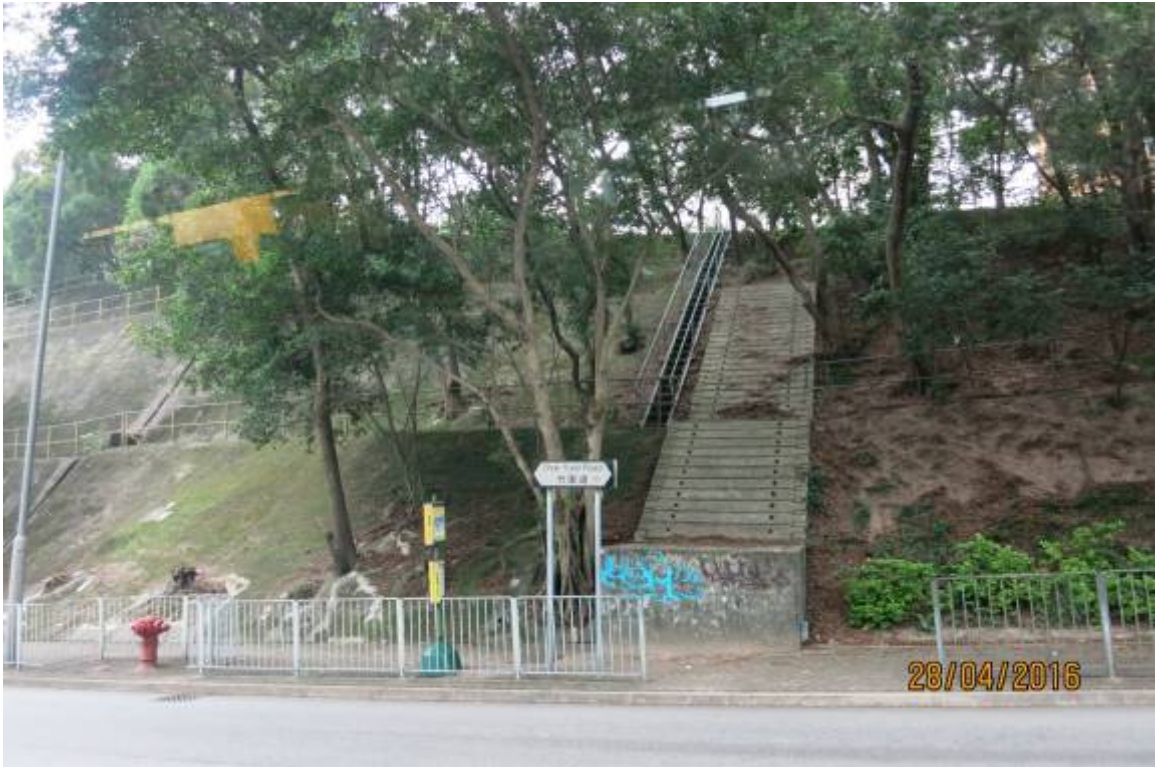
圖 46 邊坡設置巡查通道與欄杆，確保巡查人員能就近巡查與安全
