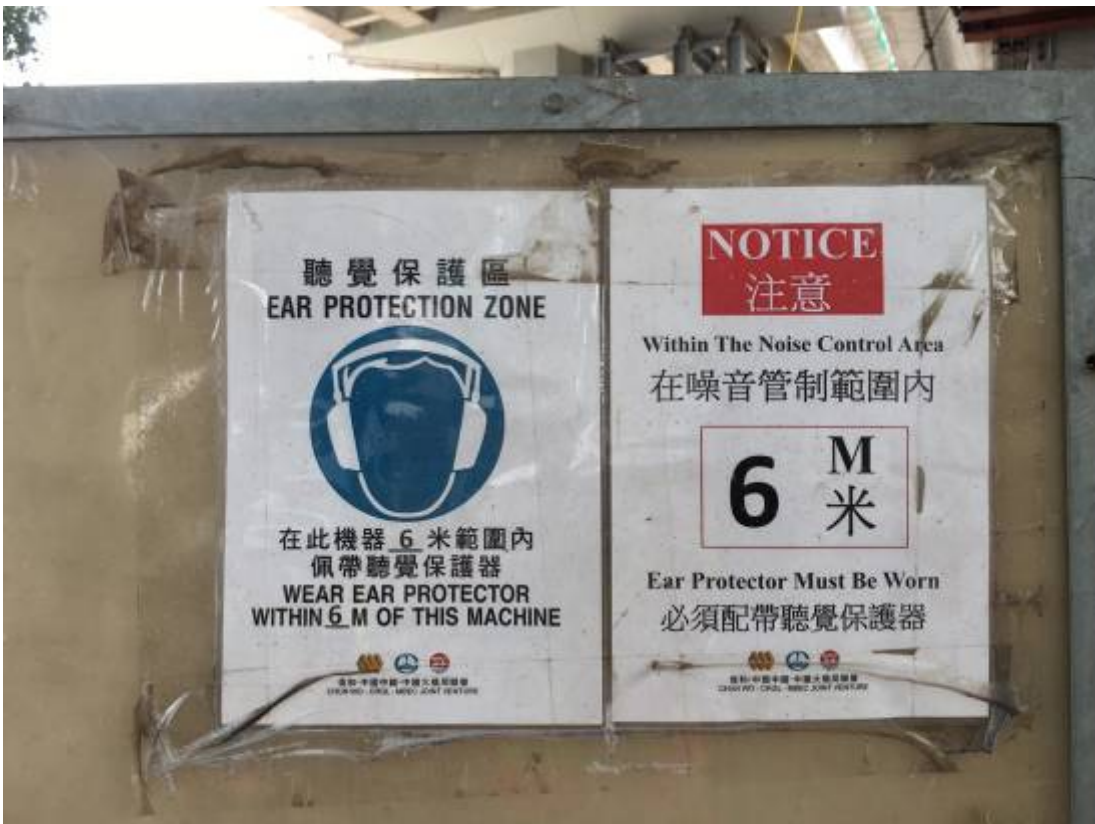
圖 37 施工現場設置聽覺保護區確保施工人員健康等設施
