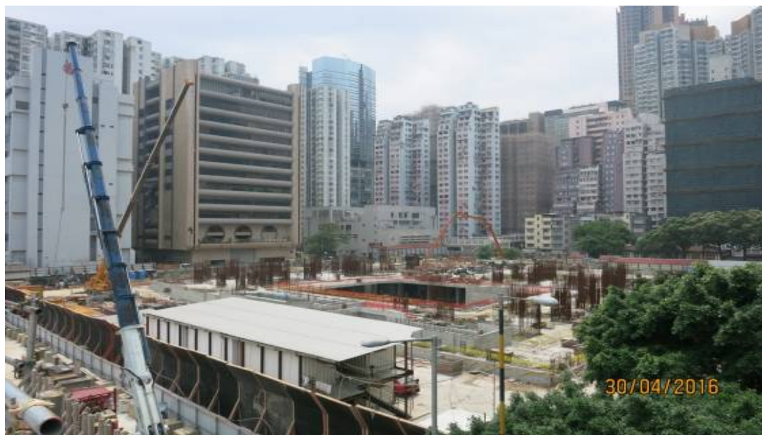
圖 20 中環灣仔繞道－北角段隧道及東區走廊連接路工程設施施工
