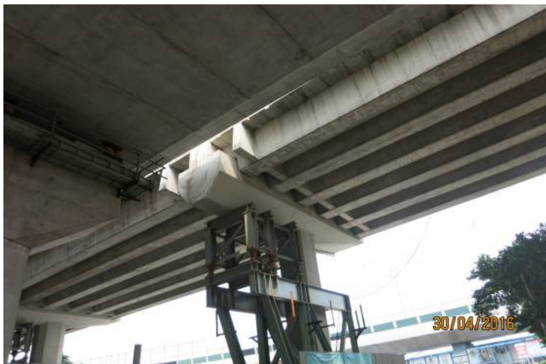
圖 16 中環灣仔繞道—北角段隧道及東區走廊連接路工程旁舊橋拆除暫留部分橋墩結構補強措施
