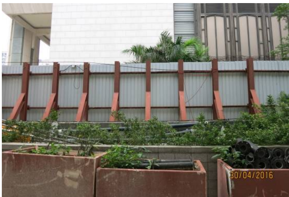
圖 21 中環灣仔繞道－北角段隧道及東區走廊連接路工程施工圍籬
