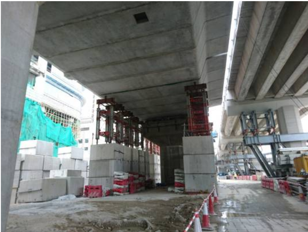
圖 15 中環灣仔繞道—北角段隧道及東區走廊連接路工程旁舊橋拆除
