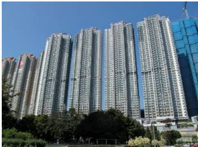
圖 28 港鐵大圍車廠開發大樓
