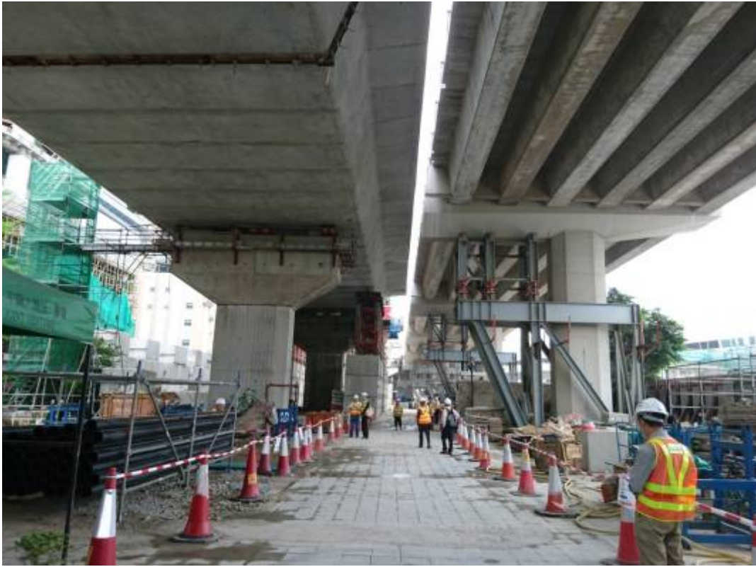
圖 14 中環灣仔繞道—北角段隧道及東區走廊連接路工程旁舊橋拆除暫留部分與新橋施工
