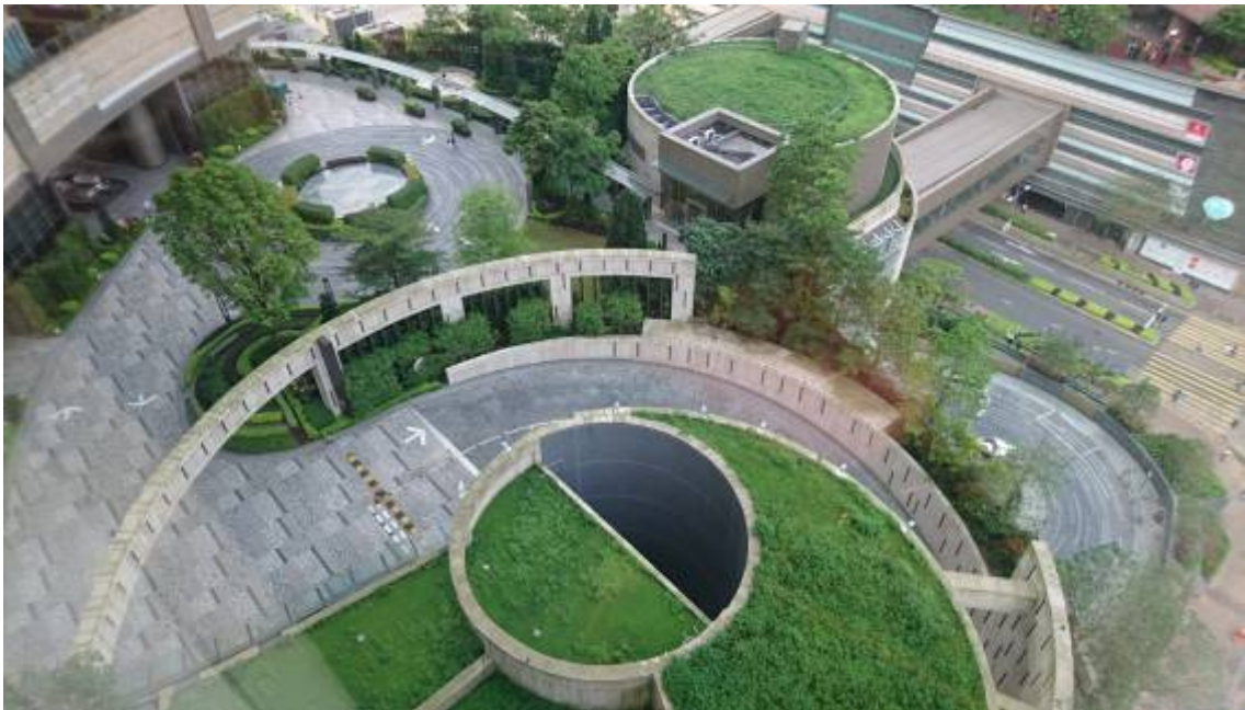
圖 58 九龍地區公宅立體綠化設施
