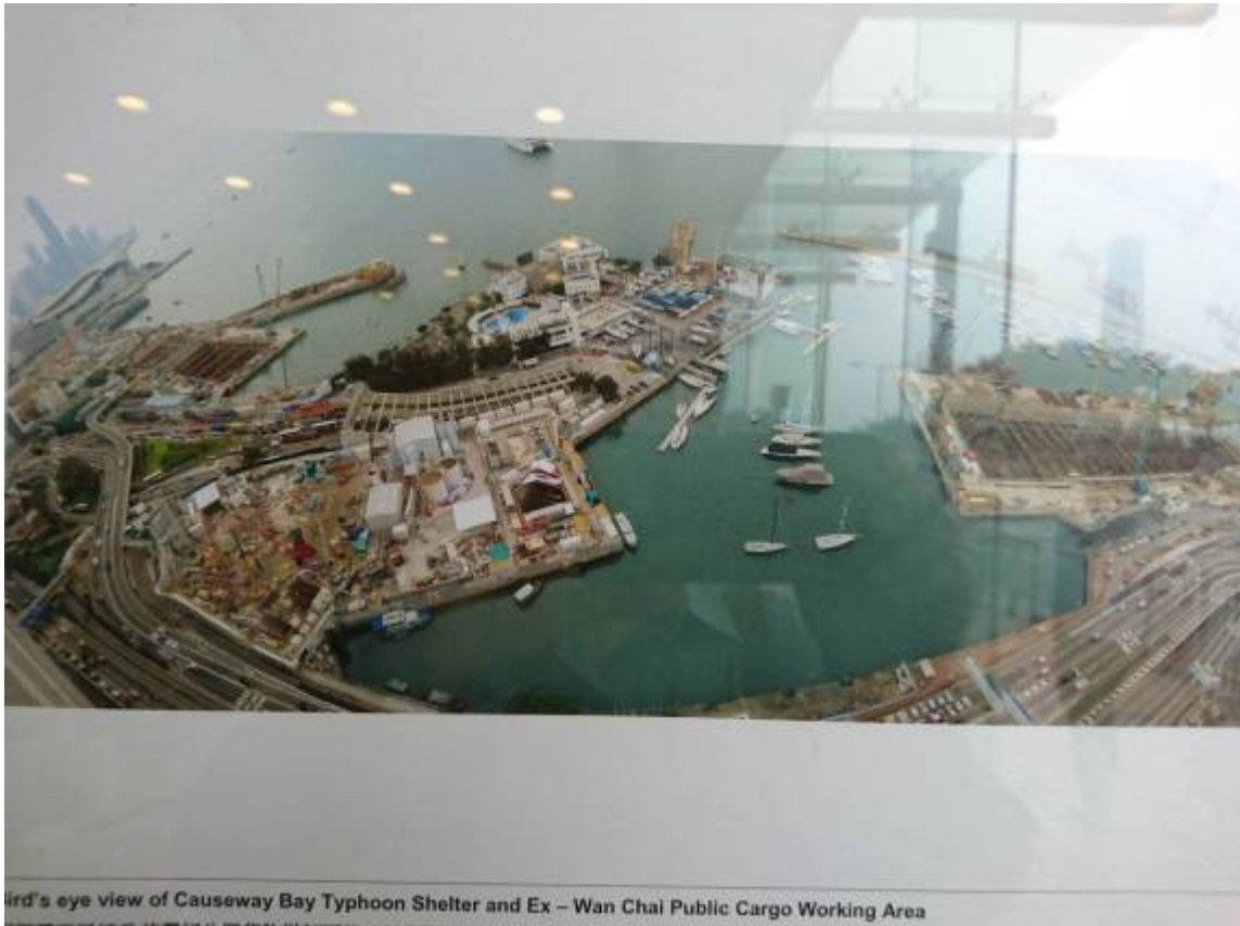
圖 12 中環灣仔繞道—北角段隧道及東區走廊連接路工程海底隧道施工區位空拍圖
