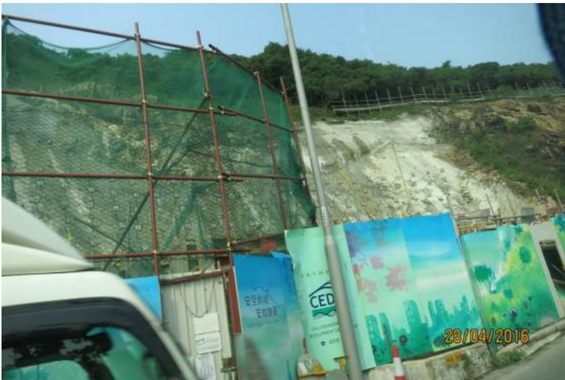
圖 49 邊坡整治與工地防護
