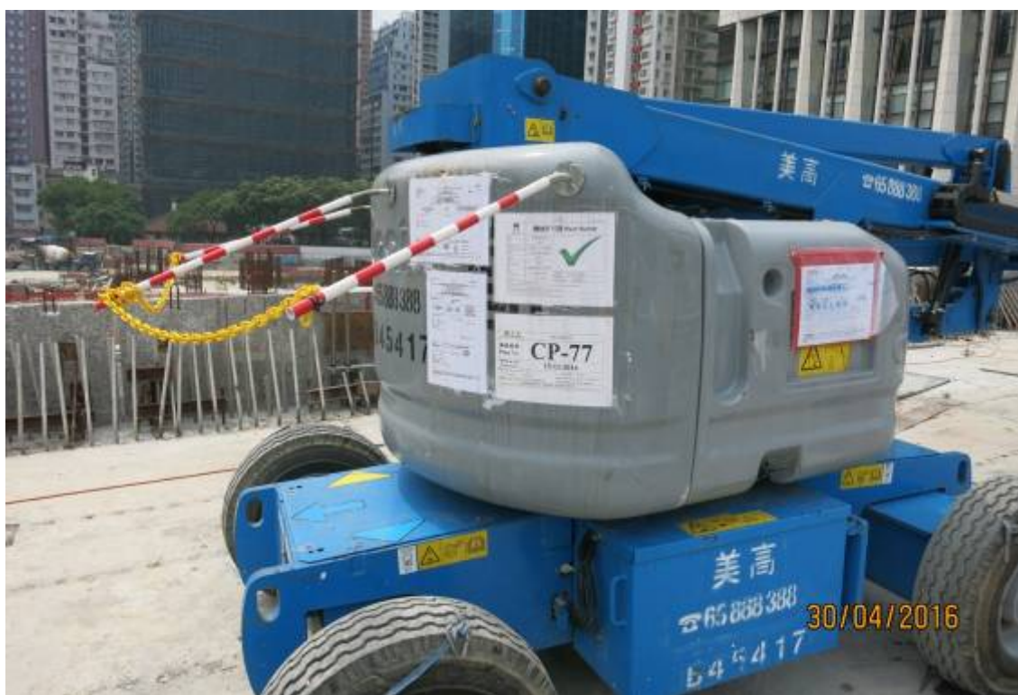
圖 33 中環灣仔繞道—北角段隧道及東區走廊連接路工程施工機具有各項核准與檢查合格文件
