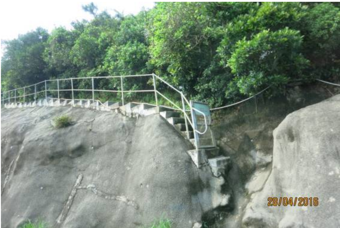
圖 47 邊坡設置巡查通道與欄杆
