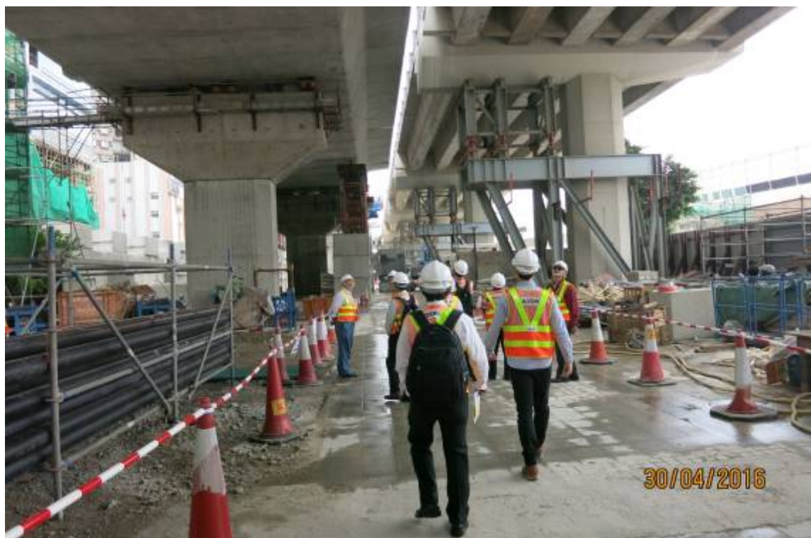
圖 17 參觀中環灣仔繞道—北角段隧道及東區走廊連接路工程高架橋施工
