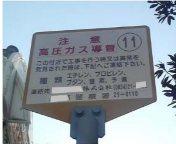
圖 2.3-14 標示高壓氣體之種類、管線異常時的緊急聯絡方式
