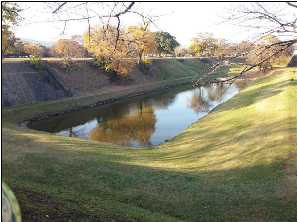
圖 2.3-36 熊本城外護城河滯洪池設計
