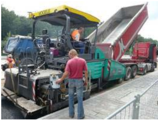
熱拌瀝青混凝土傾卸到鋪裝機
