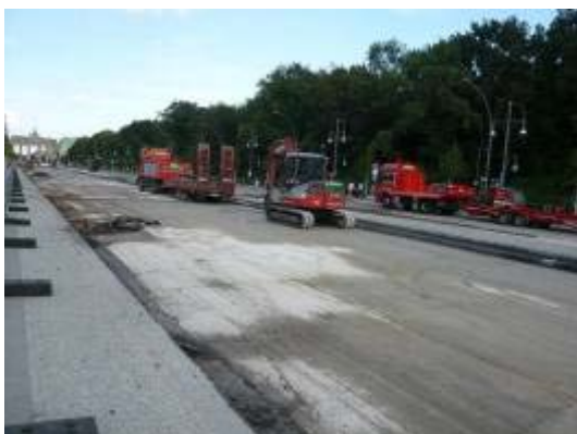
路面刨除至底層，露出底下的混凝土
