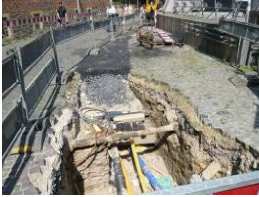
管線施工與交維
