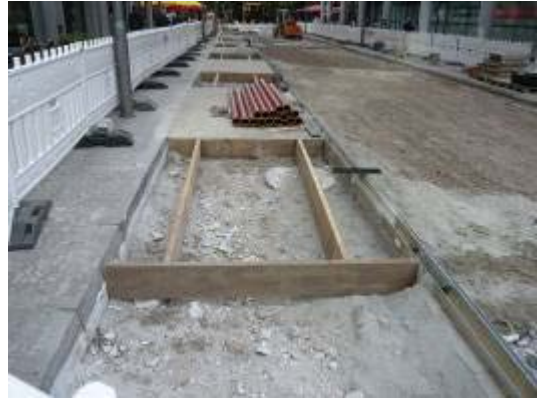
組裝後的排水溝
