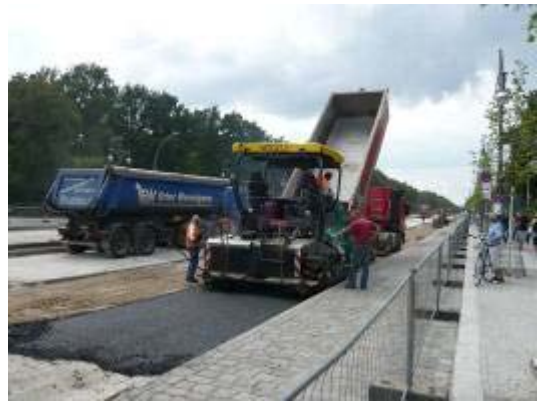
瀝青混凝土鋪設
