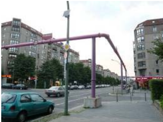
大排水管橫跨道路
