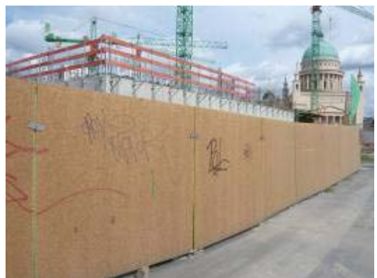
回收木材製成的施工圍籬
