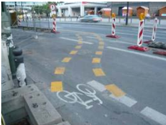
施工中自行車改道
