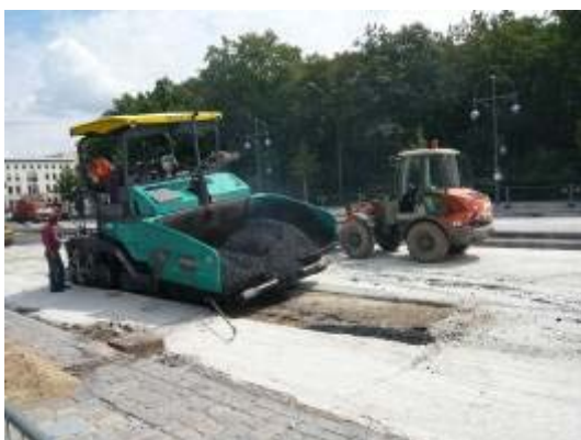
鋪裝機鋪築瀝青混凝土
