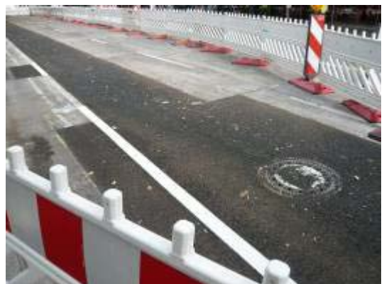
管線施工後路面修復
