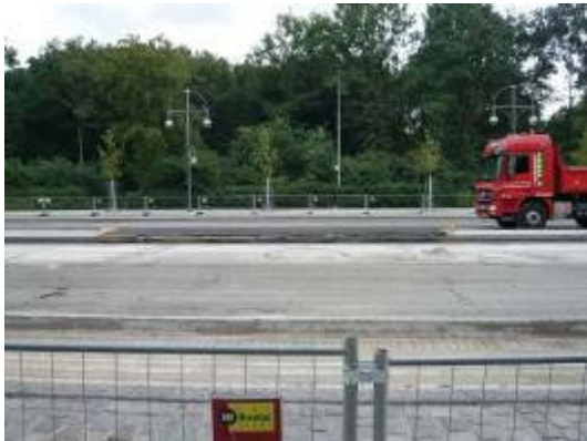
試鋪瀝青混凝土
