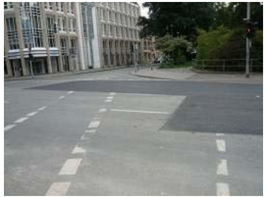
僅針對損壞處修補，未進行全斷面刨鋪
