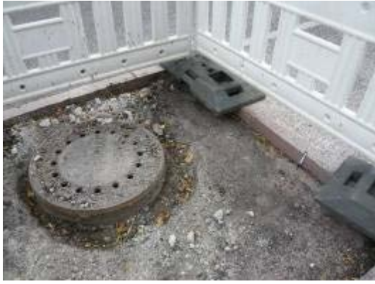
孔蓋施工，路面方正切割，挖除 10 公分
