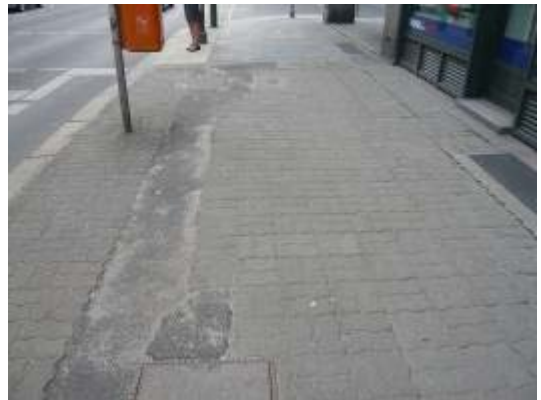
管線施工後以 AC 修補鋪面
