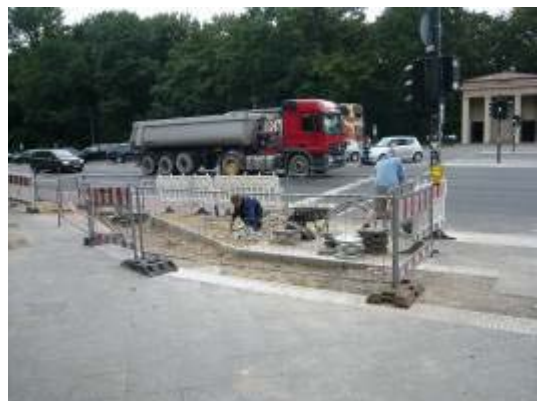
工人正在安裝地磚
