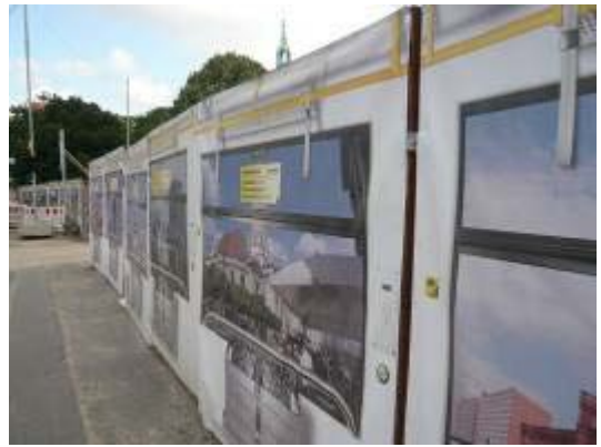
施工圍籬釘上宣傳圖片
