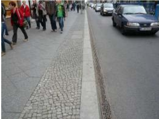
道路排水側溝
