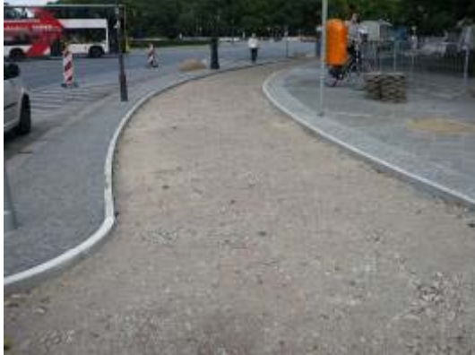
自行車道地磚挖除
