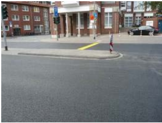
剛鋪好的柏油路面，標線都還沒畫，只貼上停止線
