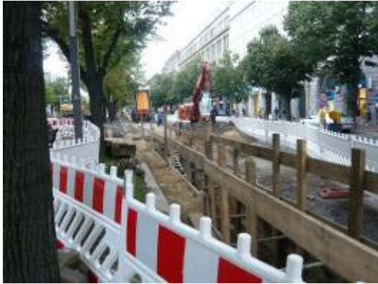
管線施工交維
