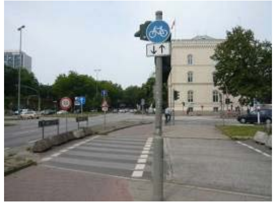
道路另一側施工，自行車道動線臨時調整
