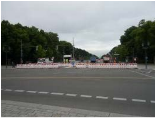
施工中，道路完全封閉
