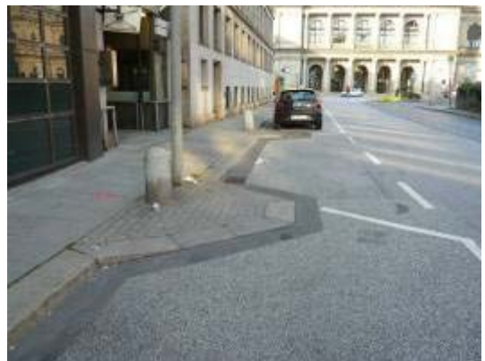
路邊停車彎與車道出入口
