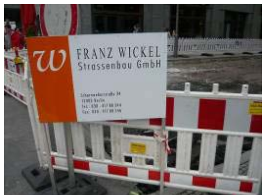
路口只放了張公司的告示牌，沒有任何施工資訊
