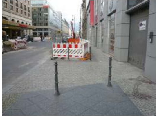
管線施工交維
