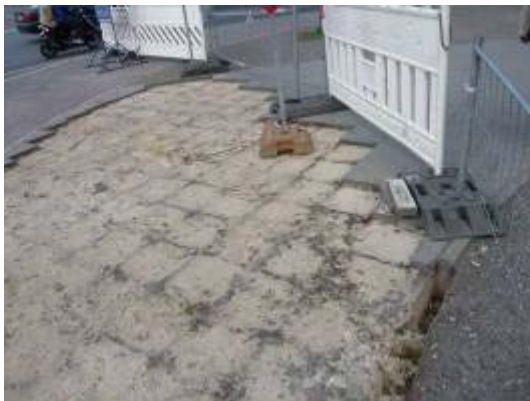
已挖起部分地磚
