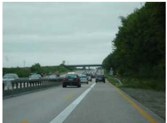
封閉半邊車道施工，同樣使用臨時標線紙
