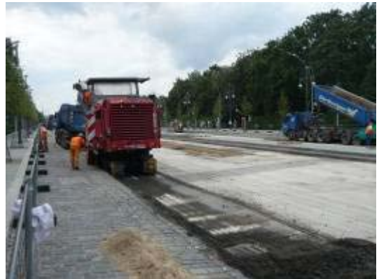
路面刨除作業
