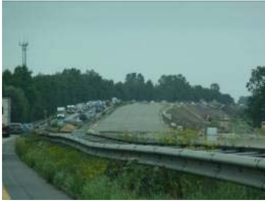
封閉半邊車道施工
