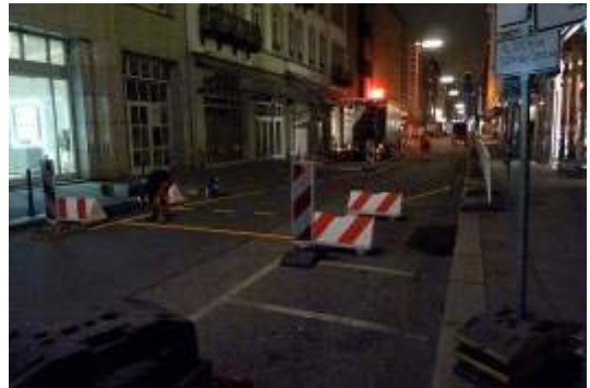
標線施工交維
