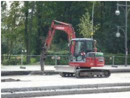
孔蓋周邊以破碎機打除
