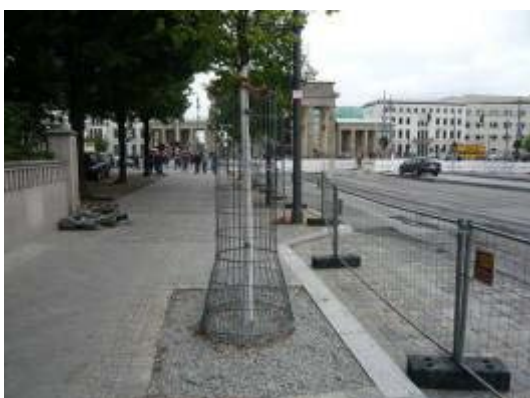
樹穴內鋪滿石子
