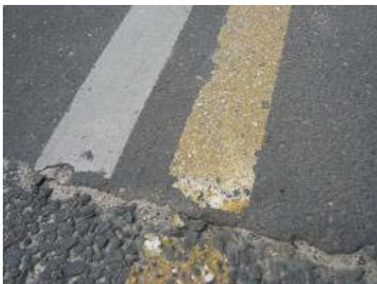
長時間使用後的標線紙，已部分脫落
