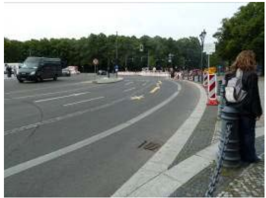
施工中，右轉標線暫時取消(直接打叉)， 設立限速 30 公里標誌牌
