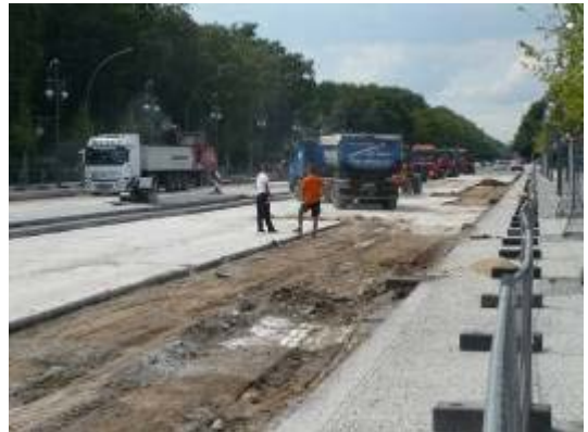
底層混凝土挖除後露出底下的砂土層
