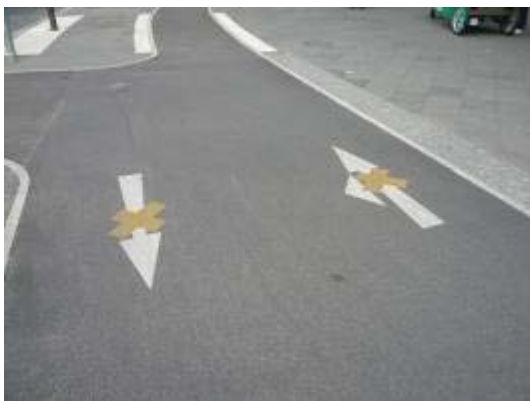
施工中，原有自行車道標線暫停使用（直接打叉）
