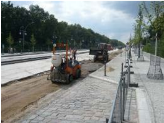
底層混凝土挖除後路基壓實
