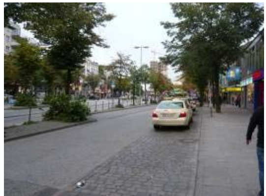
利用不同鋪面來區隔停車彎
