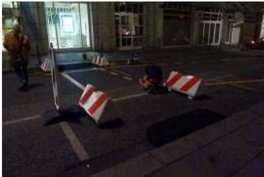
夜間標線施工
