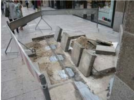
人行道施工，簡易施工圍籬
