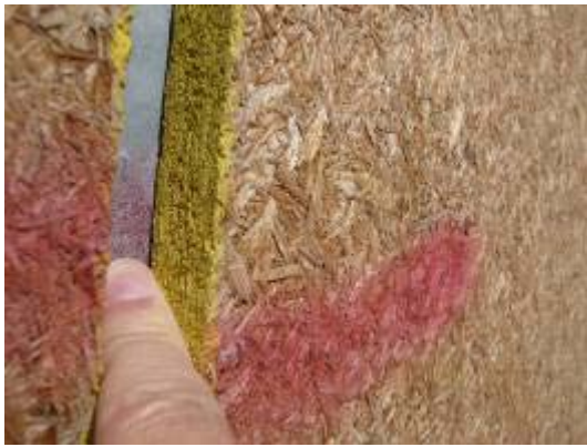
施工圍籬厚度約一吋
