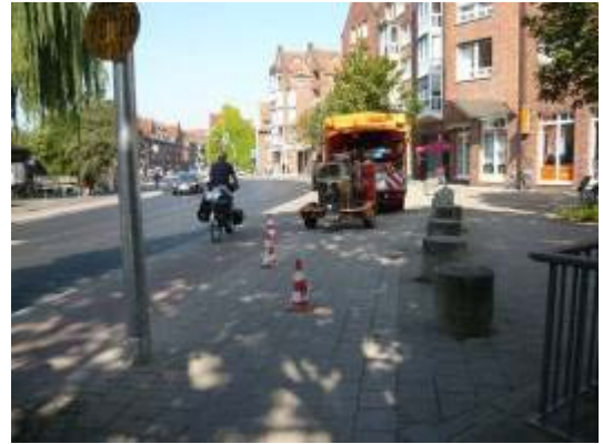
施工車輛停在人行道上
