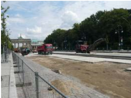
將底層混凝土分區挖除露出底下的砂土層，留下的混凝土方便工程車行駛（砂土上行駛較困難）
