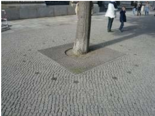
樹穴周邊有設置排水孔
