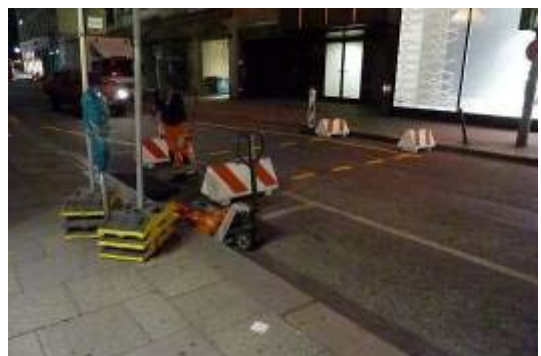
以瀝青包製作臨時斜坡道
