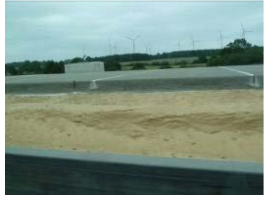
厚度約 15 公分混凝土路面
