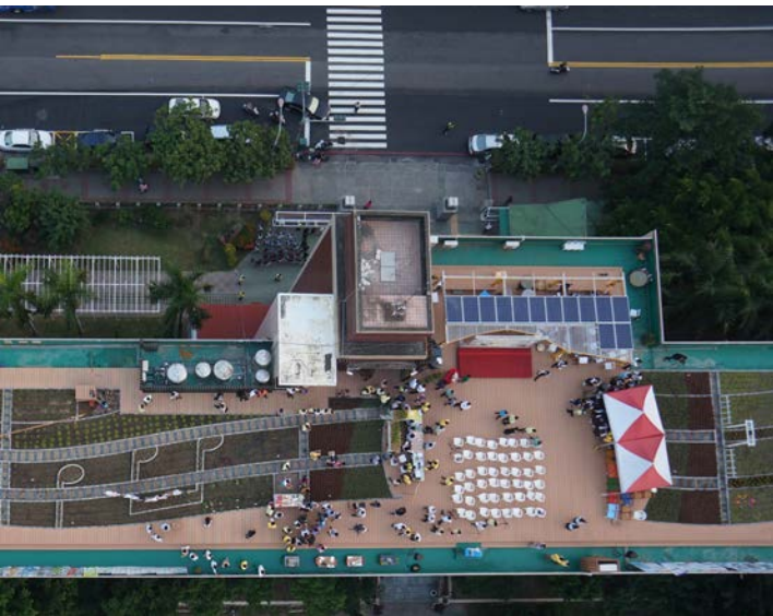
| 學校類建築 | 高雄市前金國中 設置地點 / 高雄前金區 設置類型 / 學校類 設置 容量 / 8.25 kwp 總發電量 / 10,539 度 / 年 減少二氧化碳排放量 / 5,501 噸 / 年
