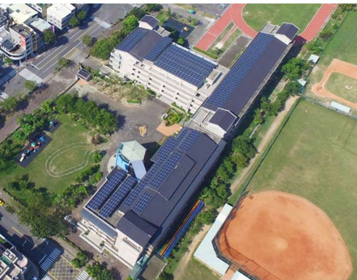
| 學校類建築 | 高雄市勝利國民小學 設置地點 / 高雄鳳山區 設置類型 / 學校類 設置 容量 / 265.68kwp 發電量 / 339,406 度 / 年 減少二氧化碳排放量 : 約 177,170 噸 / 年
