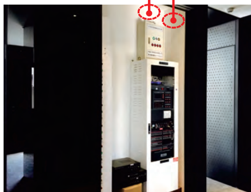
A-2. 2樓健身房外逃生門口(智慧型地震防災機制處理器x1、閃滅型出口指示燈x1)
