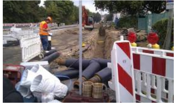
圖 24：鋪往能源碉堡熱水管路
