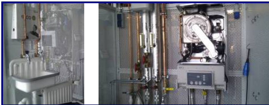
圖 17：家庭冷、熱水系統維修教具
