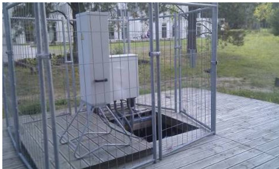
圖 46：地能熱交換系統
