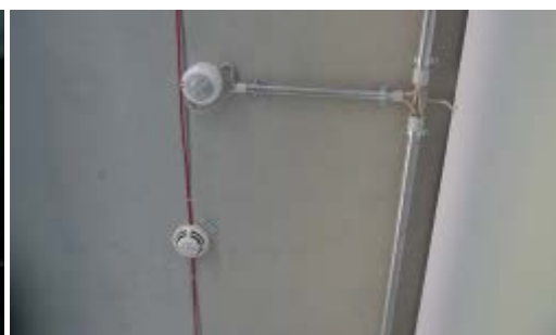
圖 14：採用智慧化建築-所有公共區域的照明都由 PIR (被動紅外傳感器) 控制
