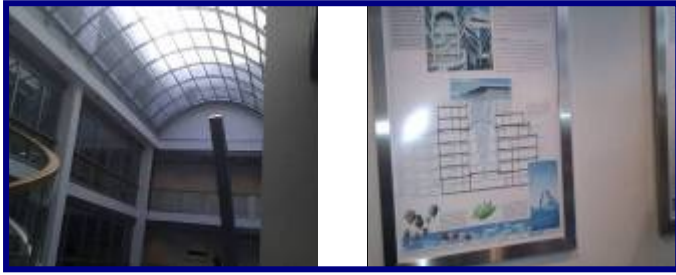
圖 34：天井利用太陽能的自然通風
