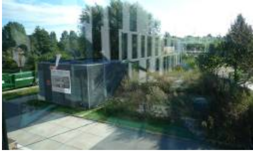
圖 13：跨季儲冷儲熱設備
