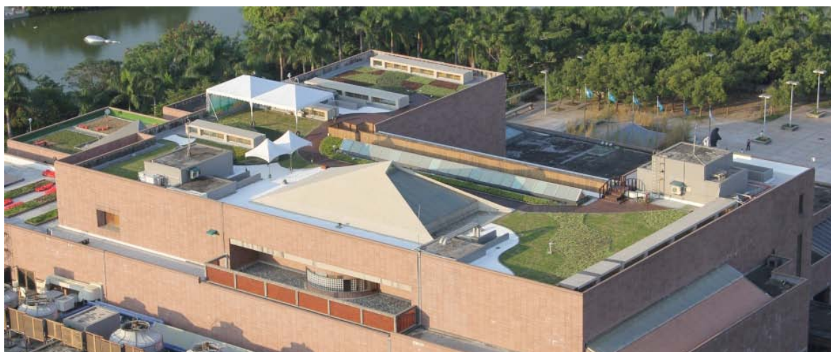
圖 1 高雄市立美術館屋頂綠化工程
