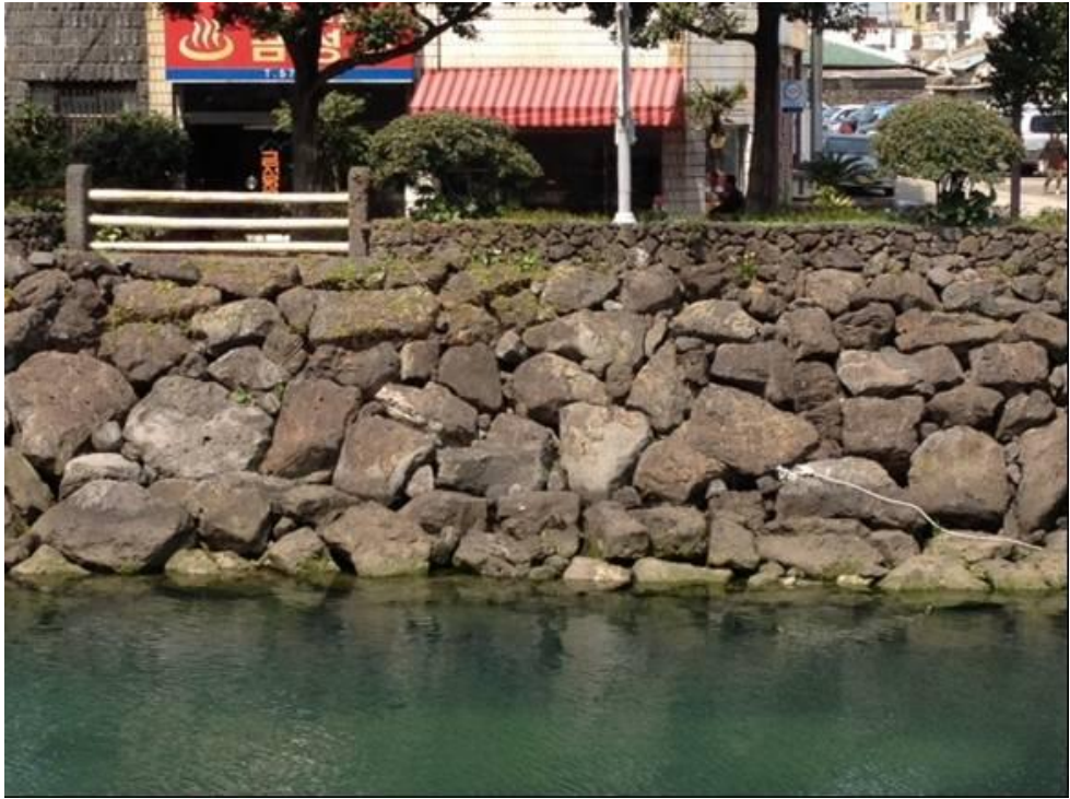
圖 佬咕石砌工法應用於河川護岸
