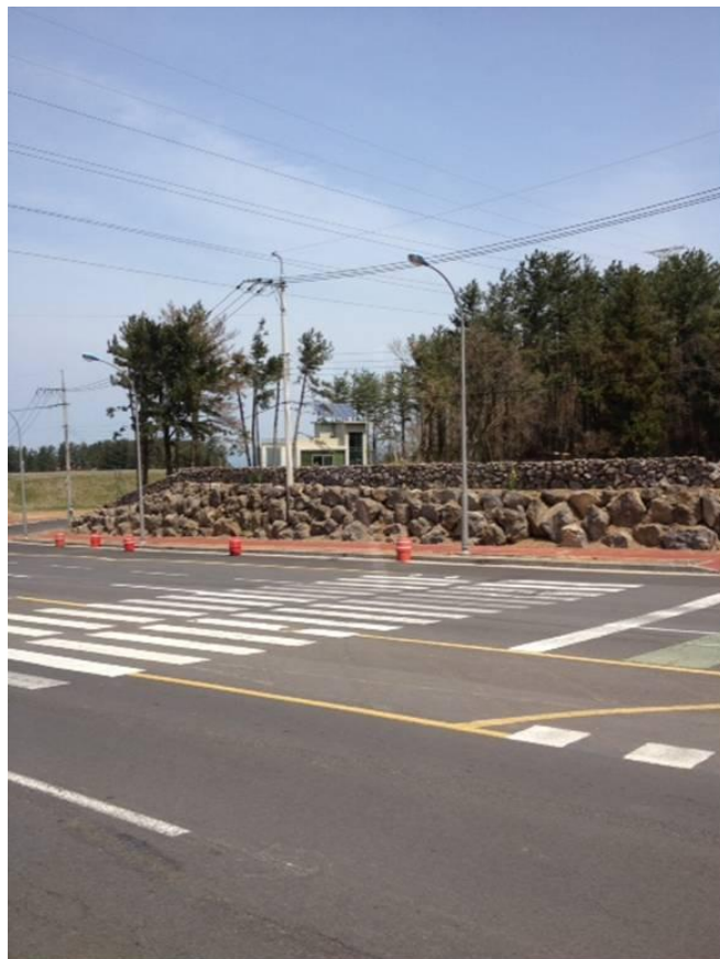
圖 佬咕石砌工法應用於道路邊坡
