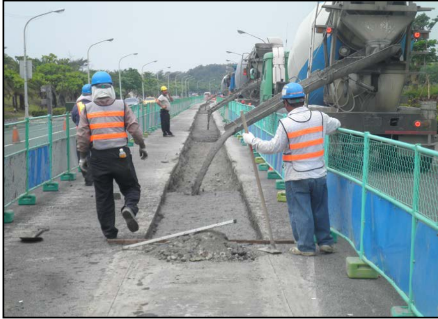
採用控制性低強度混凝土(CLSM)做為管挖後回填材料，可以有效改善管挖後道路下陷情形。
