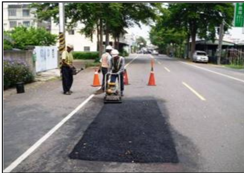
101年度4小時內完成修復比例皆在90%以上，顯示道路修復之機動性成效顯著
